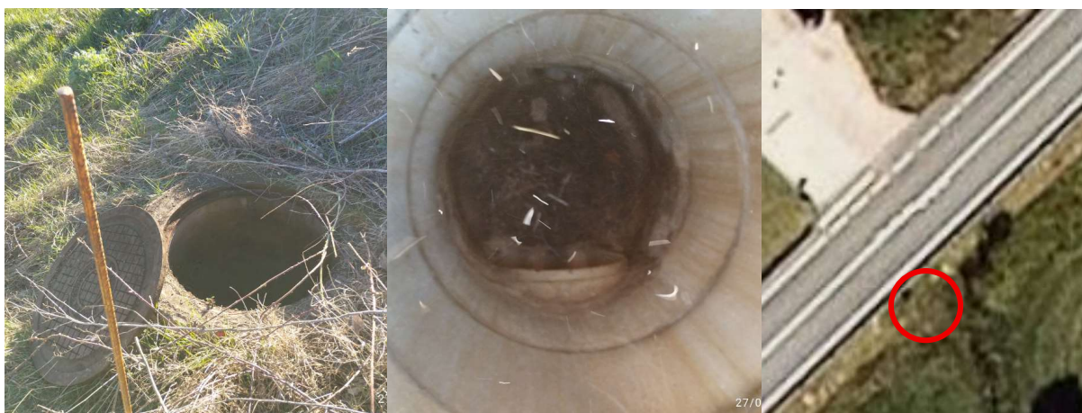
Pou 2.- Altre costat sud est de la Carretera
