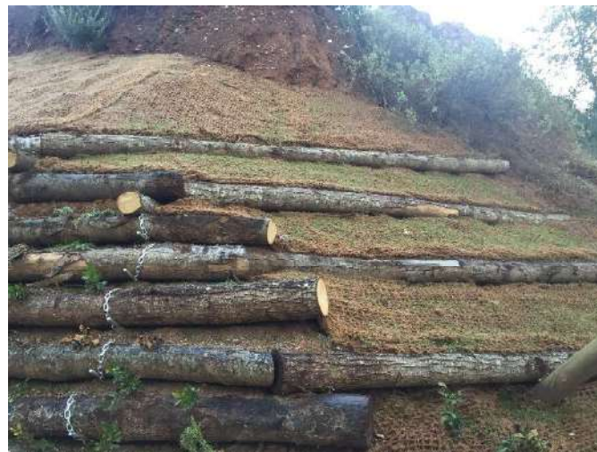
Figura 14 Imatge de transició entre un entramat Loricata i un talús
