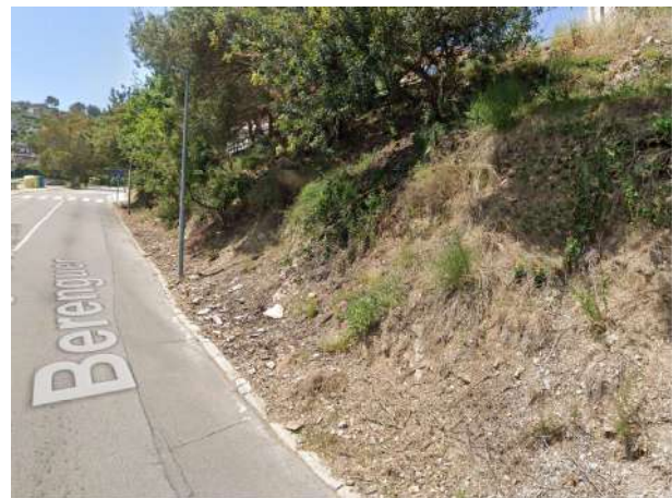
Figura 6 Tram de talús amb aflorament rocós i acumulació de terra a la part inferior
