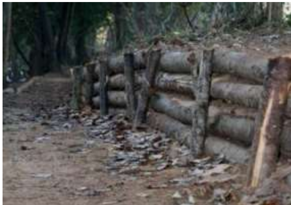
Figura 22 Exemple de palissades amb pals de castanyer i amb pal de fusta rodó executats per Naturalea
