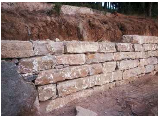
Figura 26 Imatges de murs ciclòpics
