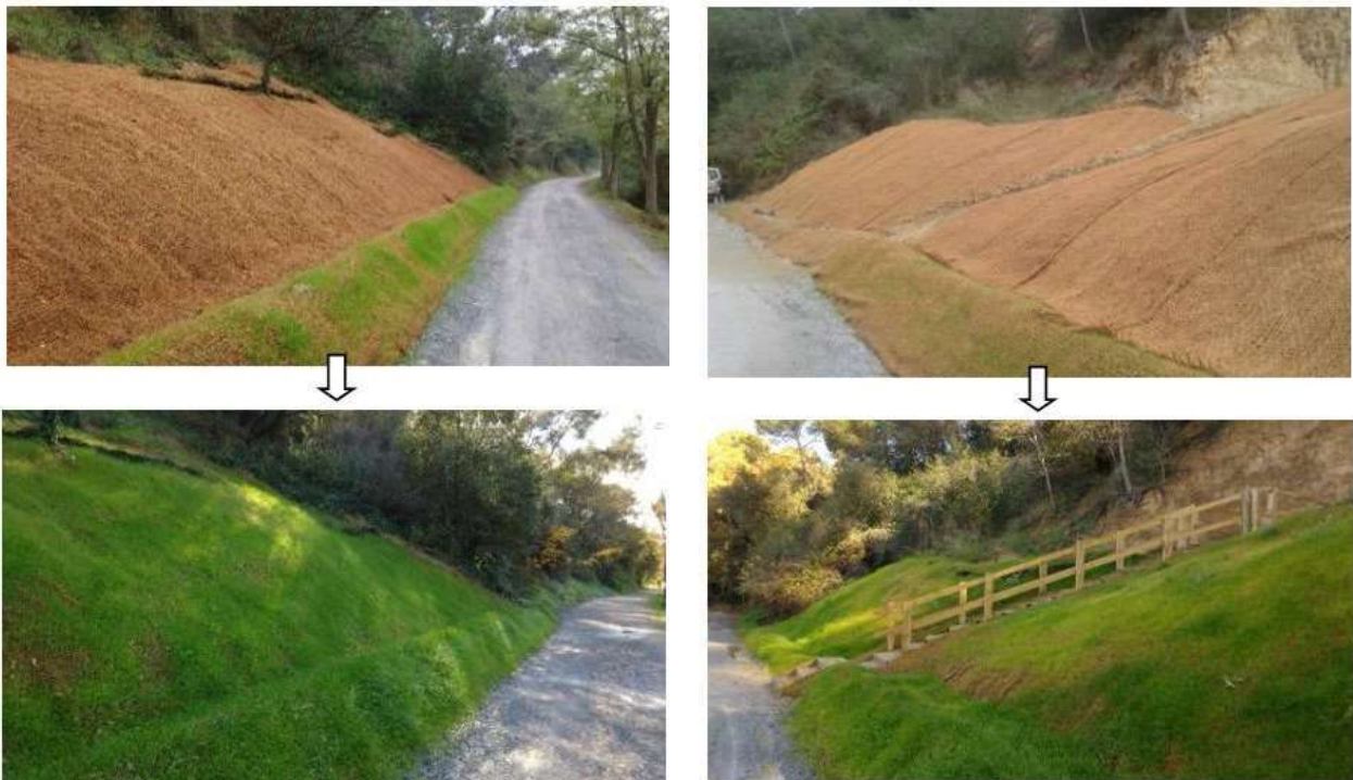
Figur. Ret de coco acabada de posar i amb la sembra ja desenvolupada
