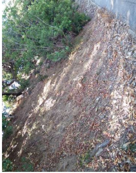
Imatge secció B-B', amb acumulació de material a la base del talús
