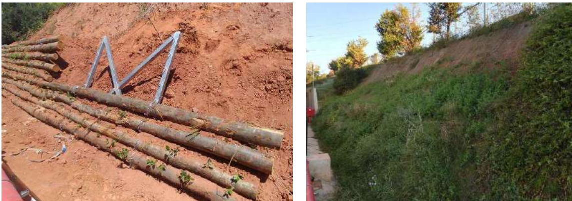
Figura 24 Procés d'instal·lació d'un entramat Loricata
