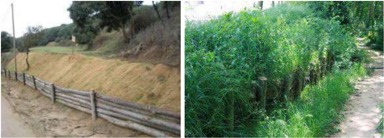
Figura 23 Exemple de palissades amb pals de castanyer i palissada amb brancatge executats per Naturalea
