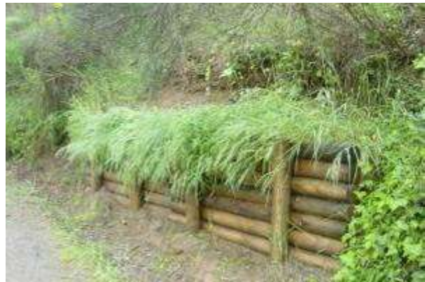
Figura 22 Exemple de palissades amb pals de castanyer i amb pal de fusta rodó executats per Naturalea
