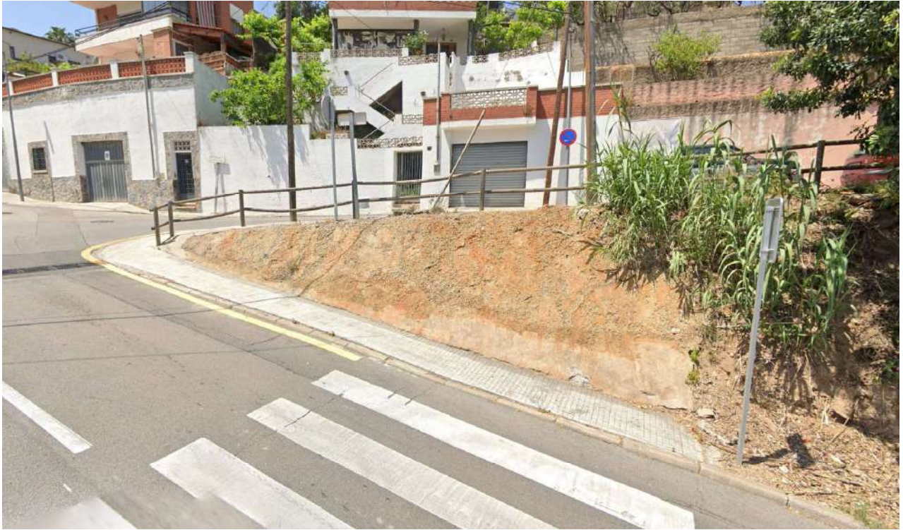
Figura 10 Darrer tram, ja a la cruïlla de carrers, completament de formigó tenyit, amb vorera, i un petit nucli de canya
