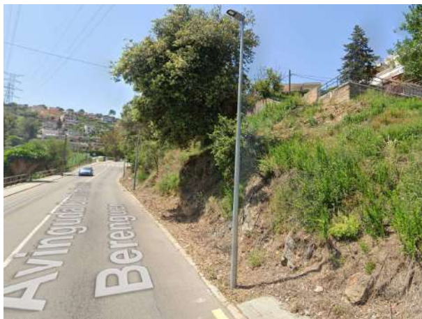
Figura 5 Inici del talús amb enllumenat a la part baixa i recobriment parcial de vegetació del talús
