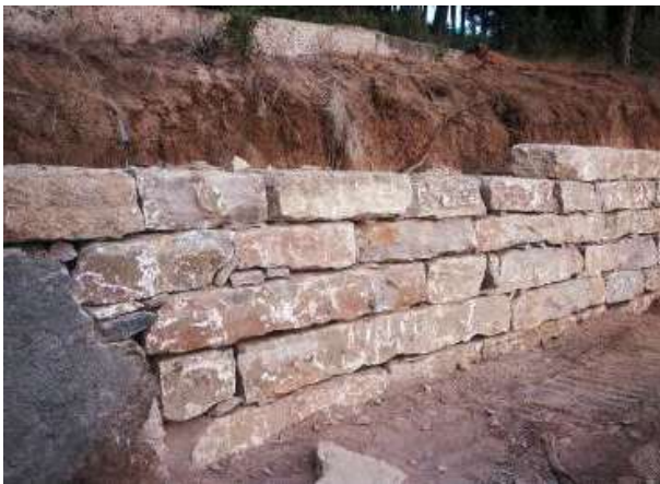
Figura 13 Imatges de murs ciclòpics
