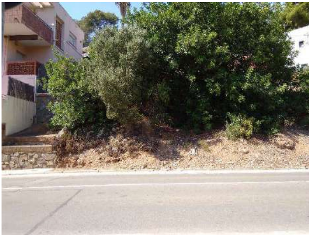
Figura 4 Tram de talús amb vegetació
