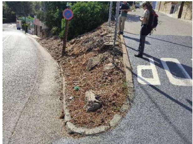
Figura 5 Tram de talús sense vegetació, amb més pendent i amb estructures diverses
