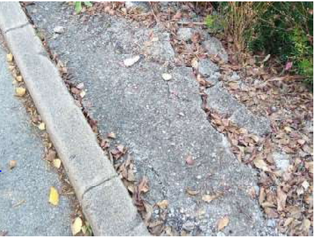
Forada on cal fer tall de formigó
