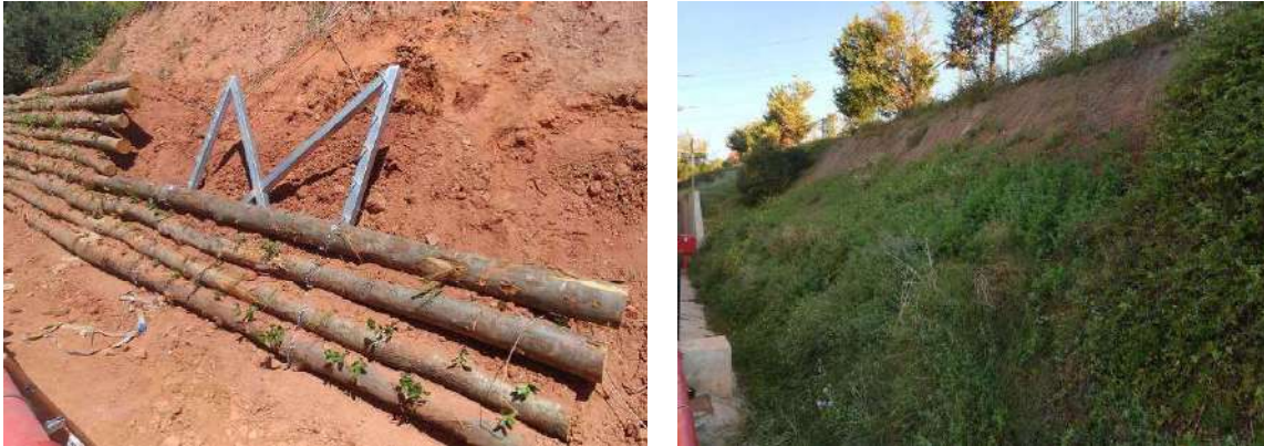
Figura 14 Procés d'instal·lació d'un entramat Loricata
