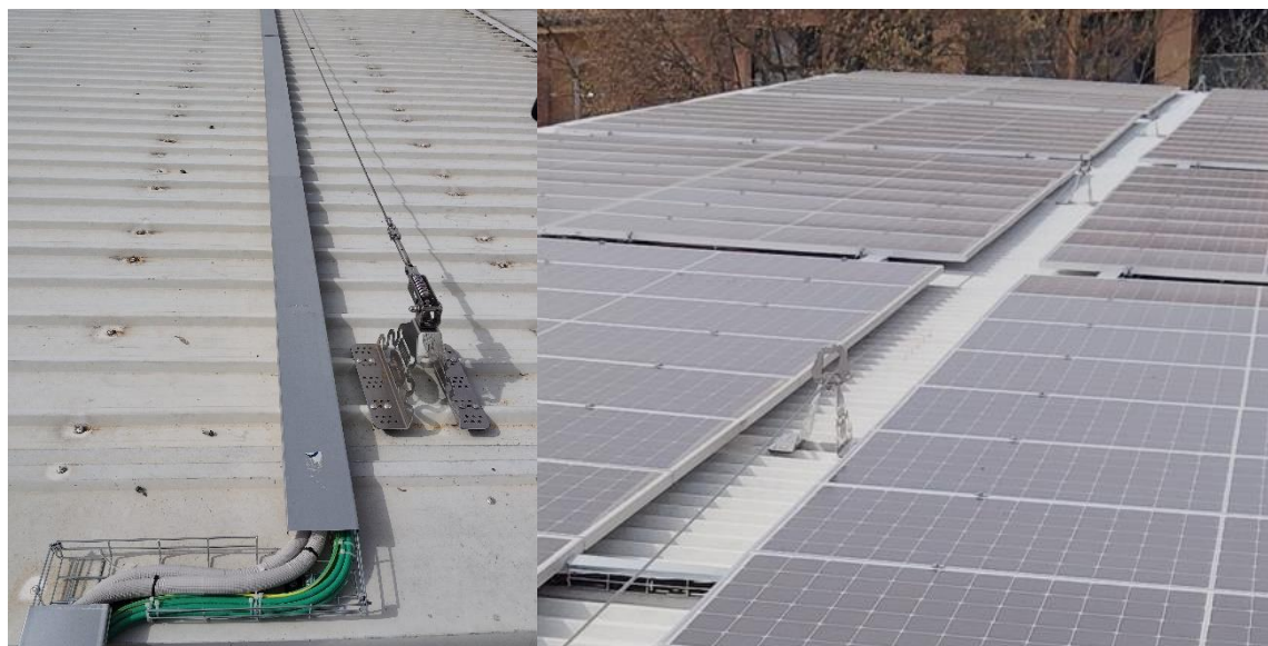
Figura 6 Exemple elements línia de vida: element als extrems i cable d'acer(esq.) i suports intermedis(drta.)
