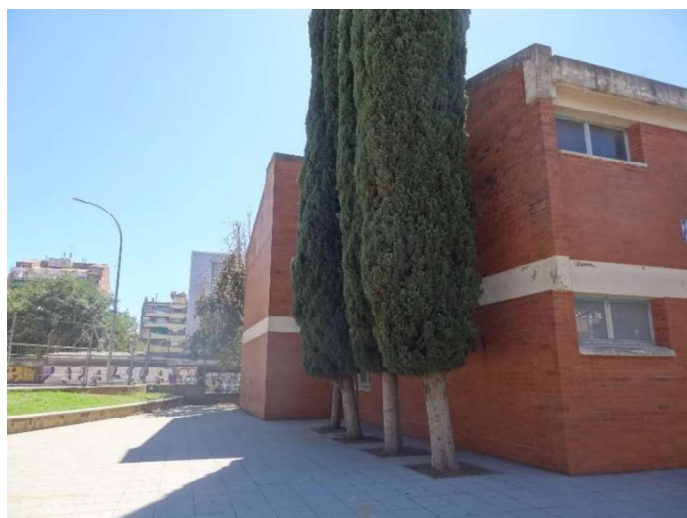
Edifici Infantil. Façana
