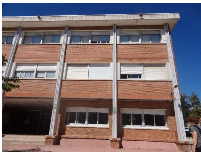
Edifici Primària. Façana
