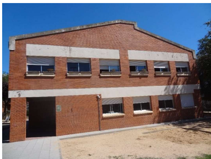
Edifici Infantil. Façana
