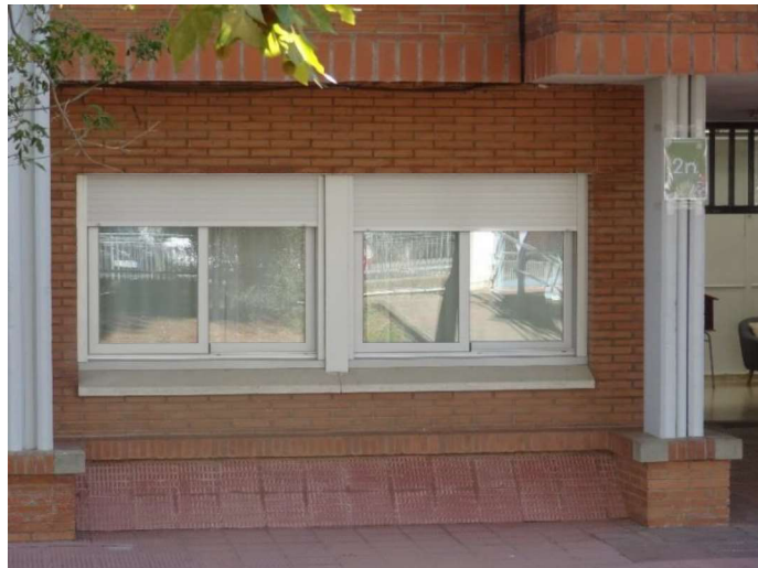
Edifici Primària. Finestra
