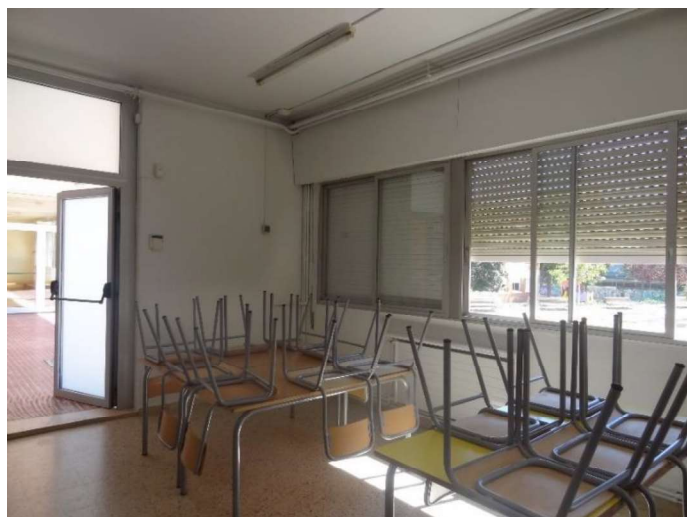
Edifici Primària. Finestra
