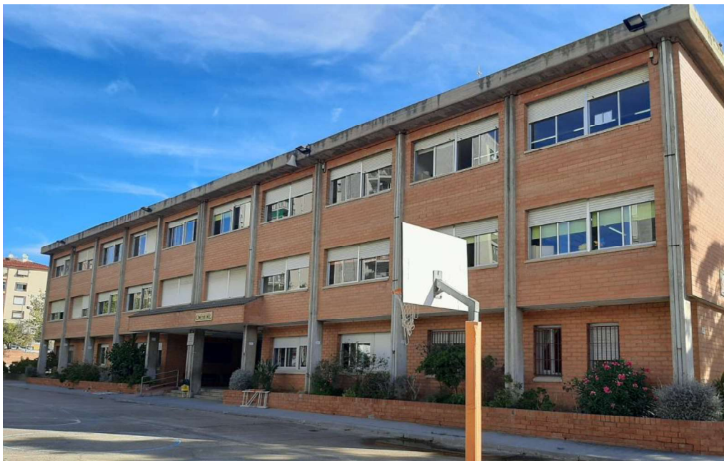
Vista exterior de la façana oest
