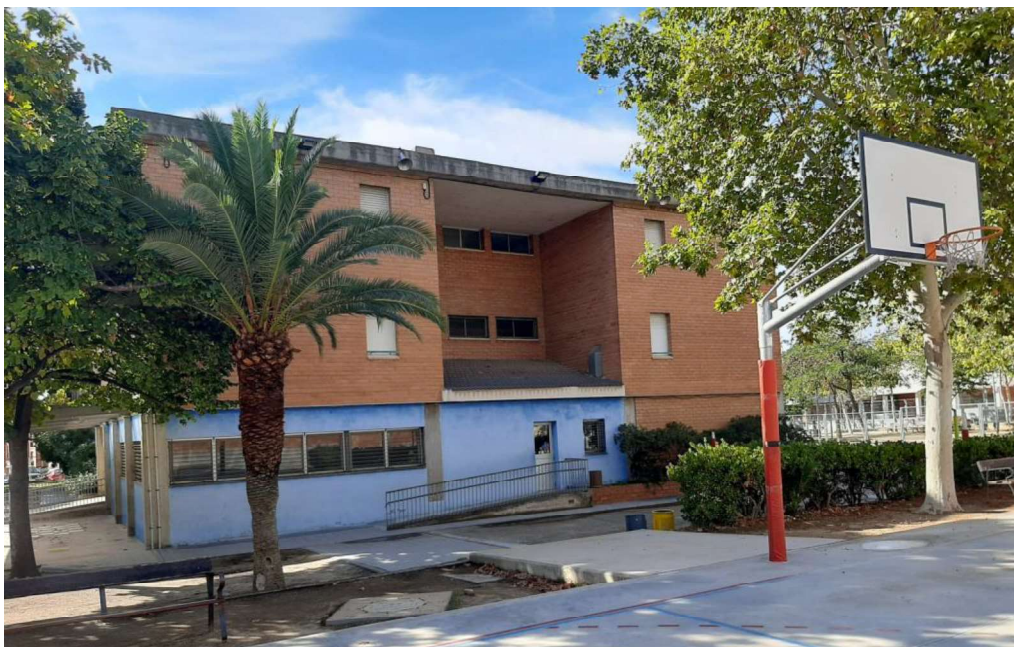
Vista exterior de la façana nord
