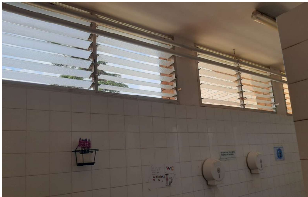
Vista interior de cambres higièniques
