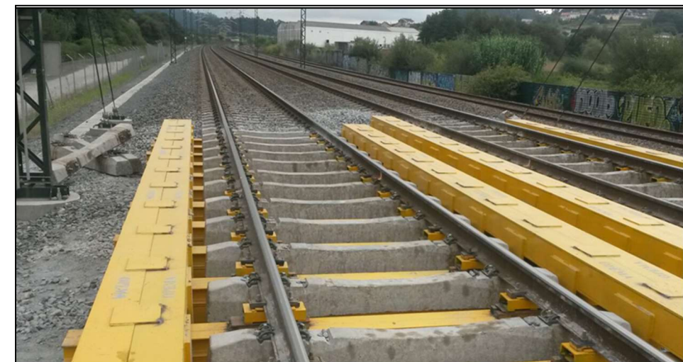
Figura 15. Exemple d'estintolament de via ferroviària
