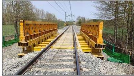
Figura 1. Pont metàl·lic provisional.
