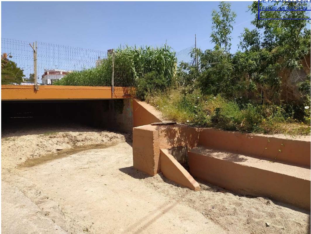
Figura 8 Detall de la sortida de la canalització executada
