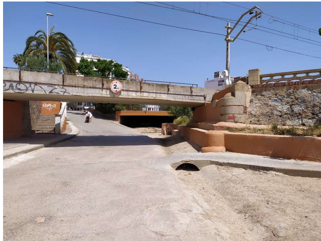
Figura 1. Pont d'ADIF i canalització executada, des de la platja
