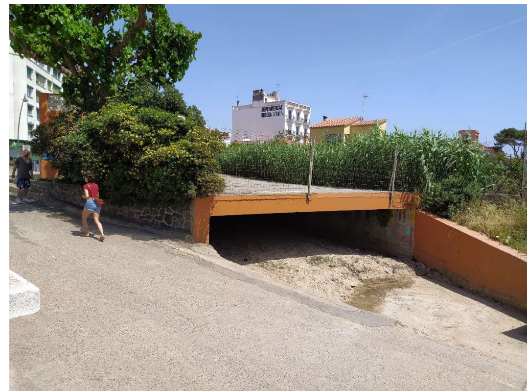
Figura 3. Detall de la sortida de la canalització executada
