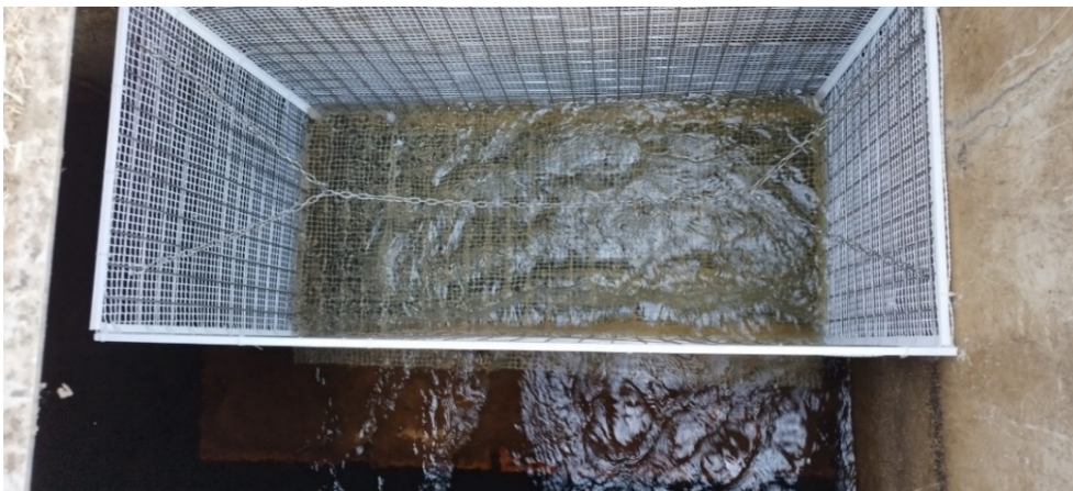
Figura 2: Sistema de retenció de sòlids existent, instal·lat l'any 2023.
