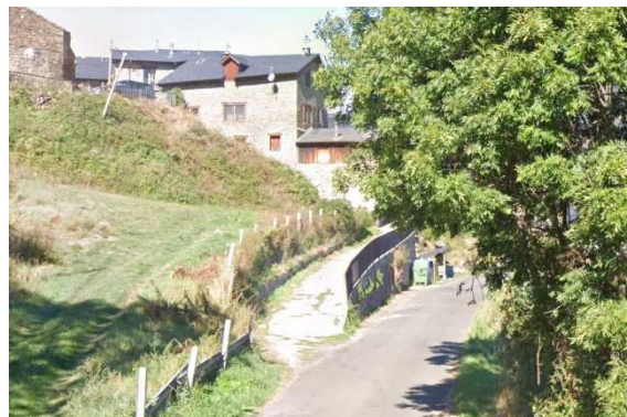
Imatge 03. Estat actual carrer límit Nord
