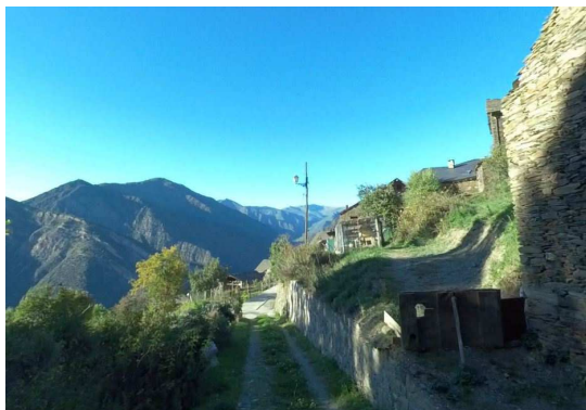
Imatge 02. Estat actual del carrer límit Sud
