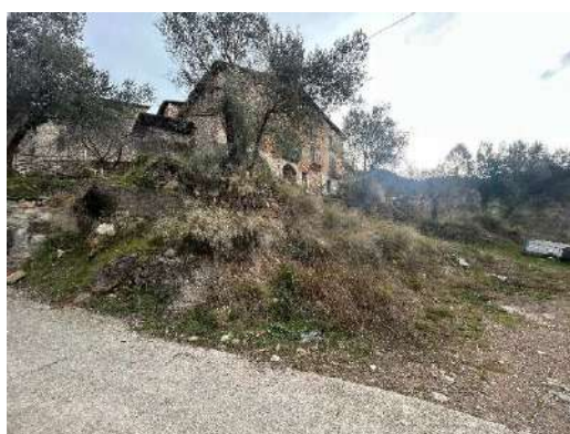
Imatge 05. Estat actual del carrer on s'actua. Baixador a carrer principal.
