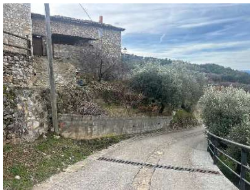
Imatge 03. Estat actual del mur.
