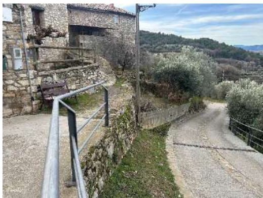
Imatge 02. Estat actual del carrer on s'actua.
