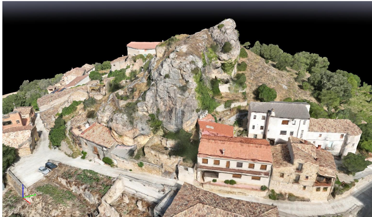
Figura 1. Imatges durant l'inspecció.
