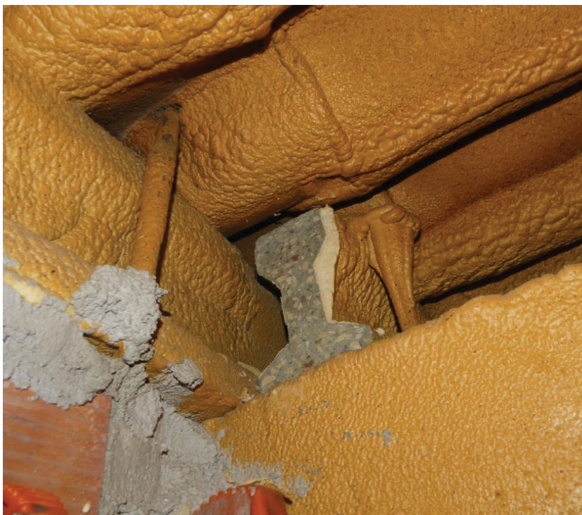
Imatge 5-2: Bigueta prefabricada de formigó.
