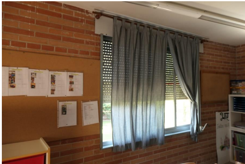
Portam existent en aules- A02
