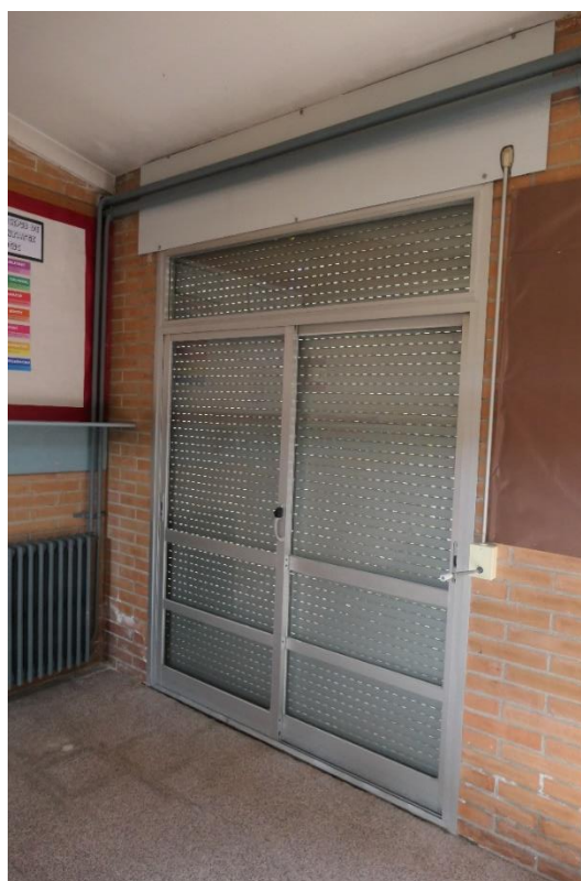
Portam existent en aules- A01
