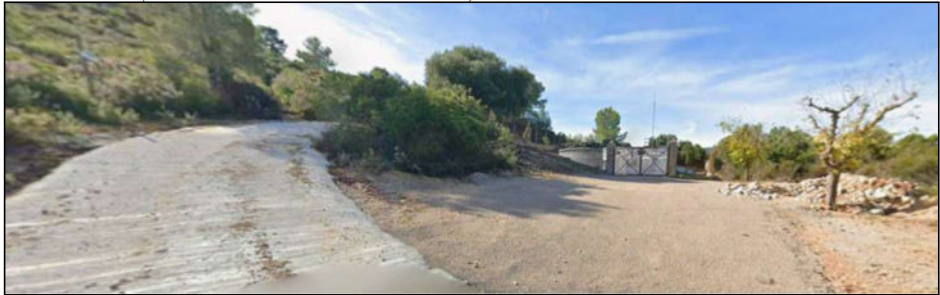
VISTA NOU DIPÒSIT DESDE CAMÍ EXTERIOR
