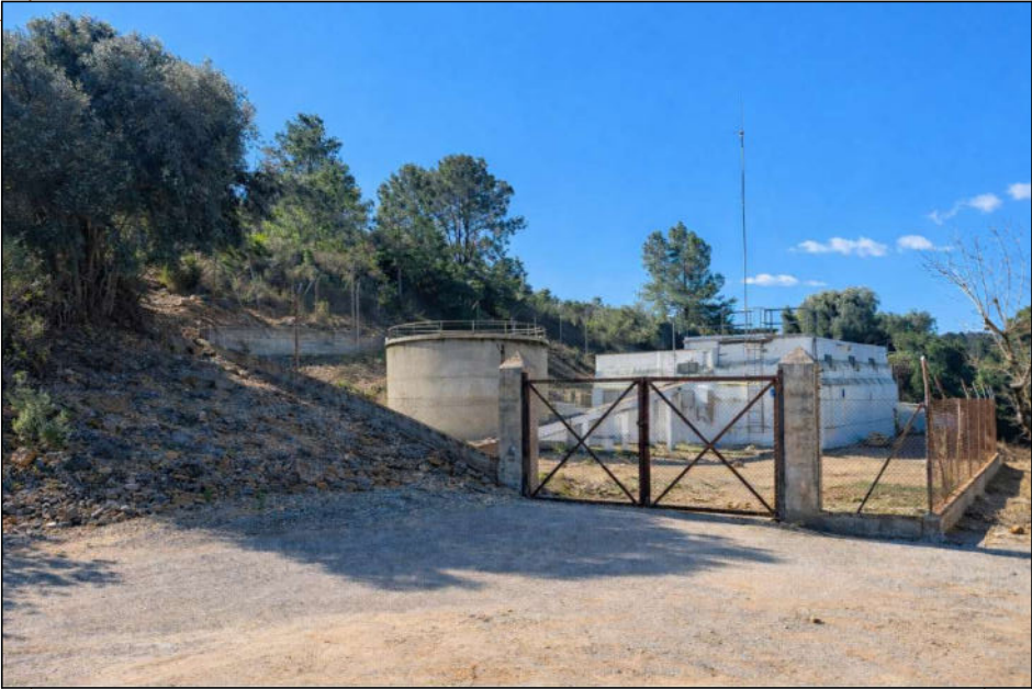
VISTA NOU DIPÒSIT DESDE CAMÍ EXTERIOR. FRONTAL
