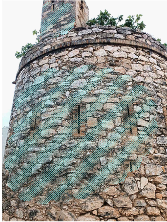
Foto 03. Pàtina negra de fongs, orientació nord, sobre paredat i material ceràmic.
