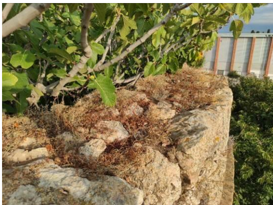
Espessor considerable mur planta baixa-espitllera.
