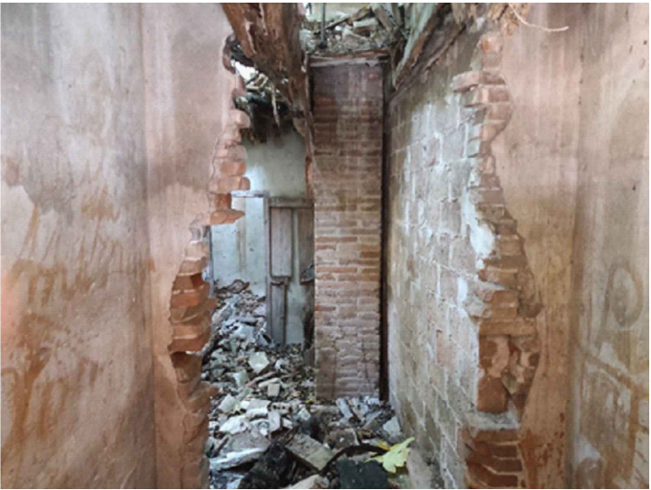
Foto 04. Interior torre, divisòries i pilar central de totxo massís 45x45, runa i brossa acumulada. Planta Baixa.
