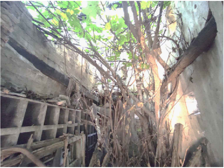
Foto 02. Interior torre, jàssera, envans i restes d'embigat.
