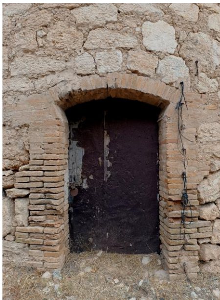
Porta de fusta revestida amb planxa de ferro.
