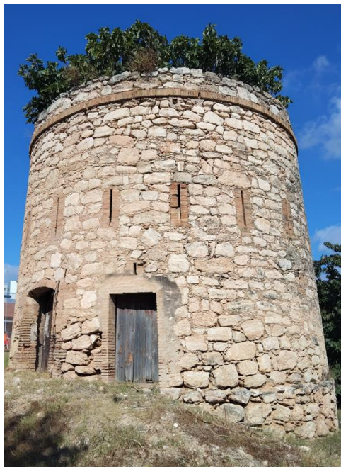
Perpectives de l'exterior de la torre (setembre 2025)
