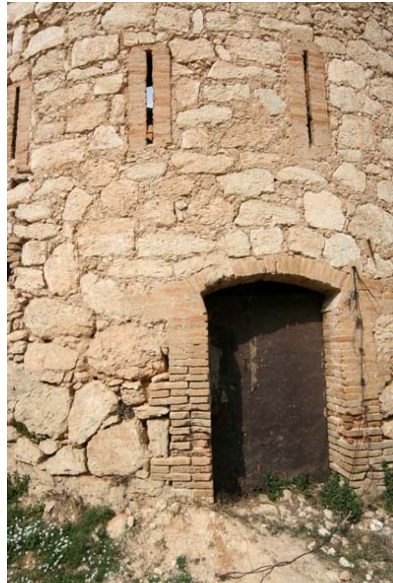
Detall del portal d'entrada i d'espitlleres emmarcades amb fàbrica de totxo
