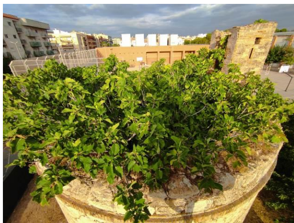
Coberta i badalot escala, al fons. Vista a Oest
