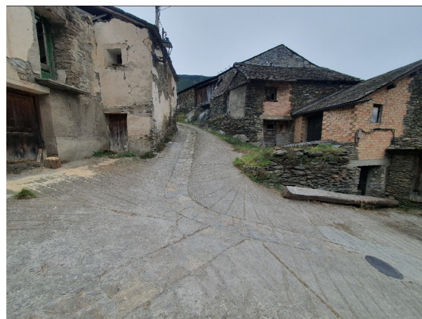
Actuació 02. Tram a pavimentar, substituir canonada de fibrociment i renovar clavegueram. Reducció de cota en punt clau i de part de la base de pavimentació per millorar circulació de vehicles.
