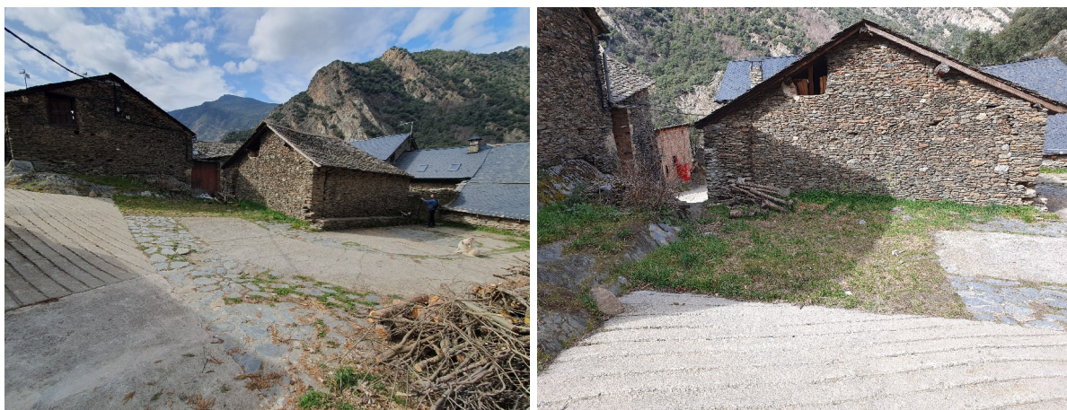
Actuació 03. Tram de paviment empedrat a substituir i zona sense pavimentar a pavimentar, amb un tram de formigó i un altre de nou paviment empedrat seguint l'estètica de la plaça.
