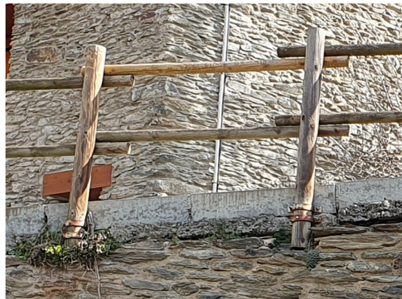
Actuació 05. Tram on consolidar el reblert del mur de contenció, re pavimentar i reposar la barana de fusta present per millorar-ne l'ancoratge.
