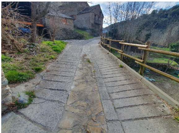
Actuació 05. Tram on consolidar el reblert del mur de contenció, re pavimentar i reposar la barana de fusta present per millorar-ne l'ancoratge.
