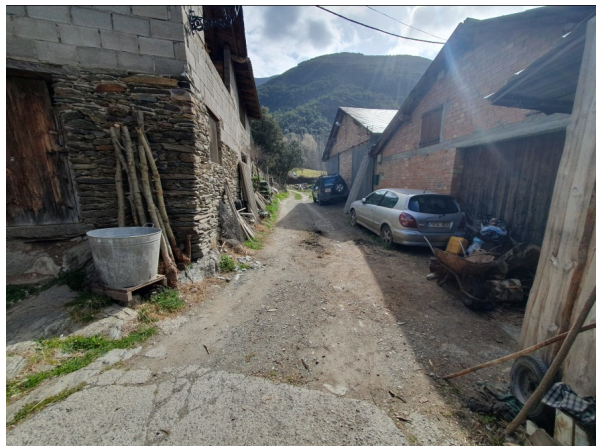
Actuació 01. Tram a pavimentar. Instal·lació d'embornal, nou pou de registre i connexió entre ells.
