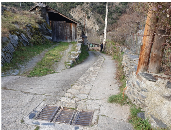
Actuació 02. Tram a pavimentar, substituir canonada de fibrociment i renovar clavegueram. Reducció de cota en punt clau i de part de la base de pavimentació per millorar circulació de vehicles.
