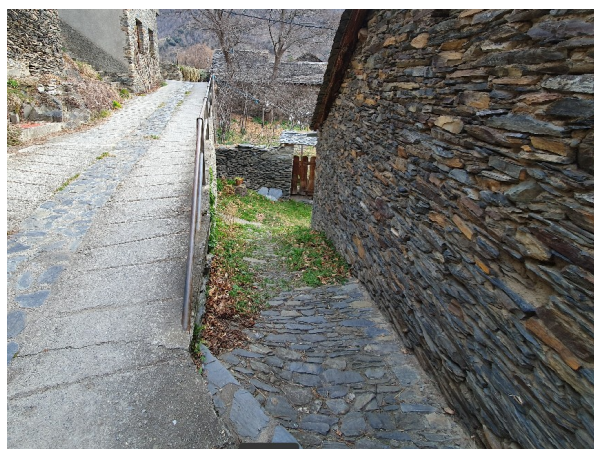
Actuació 10. Carrer a pavimentar. Tram de vianants (dreta) amb pedra natural com l'actualment present al poble rejuntada amb morter, i la part per de la rampa per vehicles (esquerra) amb formigó amb fibres i nervi central de pedra.
