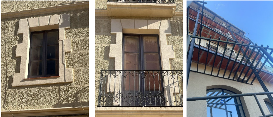
Imagen ventanas de madera y pórtico estructura metálica
