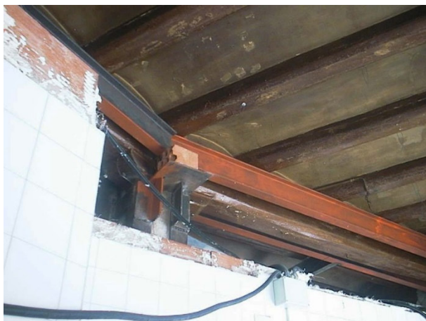
Imagen refuerzo estructural con vigas metálicas
