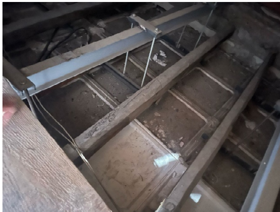
Imagen forjado de cubierta con refuerzo estructural con vigas metálicas
