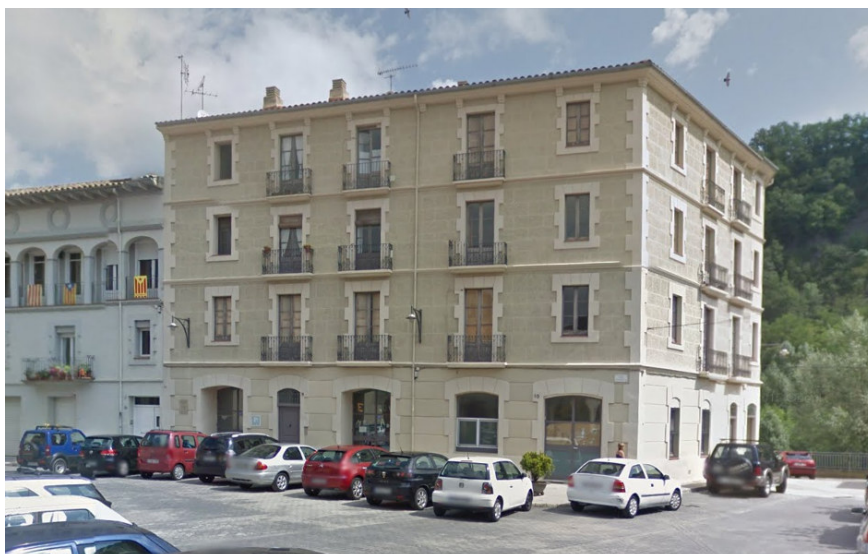
Façana principal, estat actual, Edifici Pl. de la República Num 9, façana a la plaça, vista des del carrer Sant Boi
