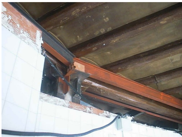
Imatge reforç estructural amb bigues metàl·liques
