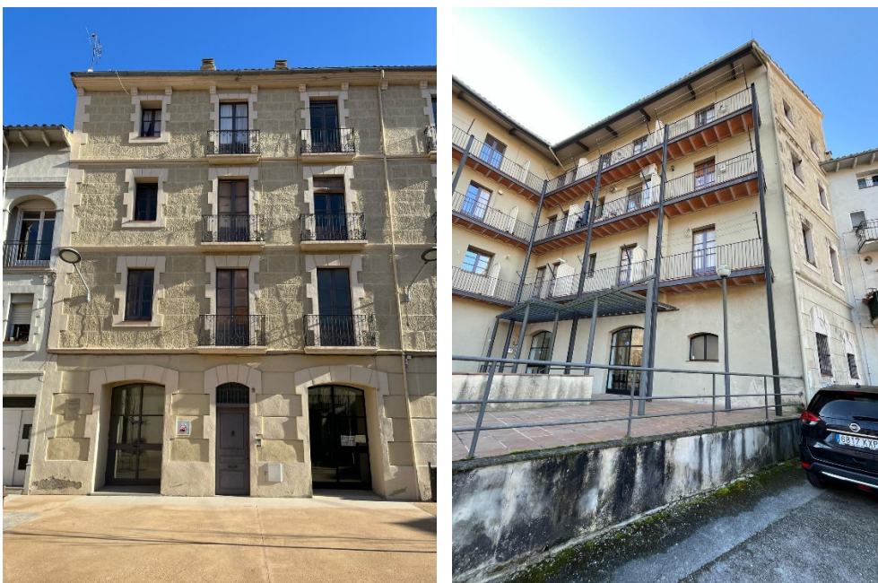
Façana principal i posterior de l'edifici objecte de concurs
