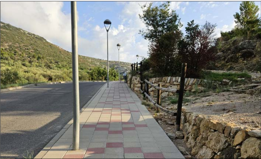
5- Tram de vorera existent
