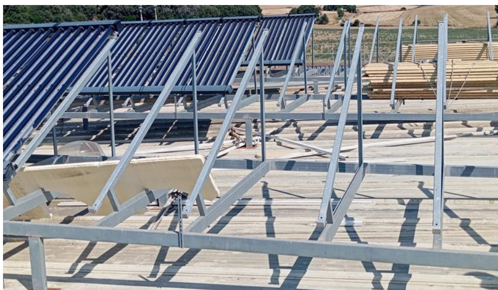
Fig. 9. Instal·lació tèrmica existent a ser desmantellada
