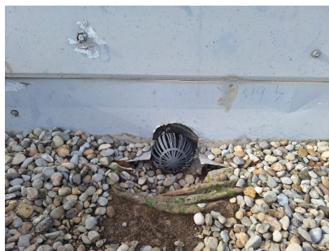
Vista d'una de les gàrgoles de seguretat executades en posterioritat a la coberta.
