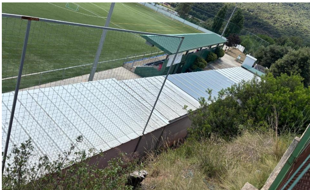
Fig. 4 - Vista de l'edificació existent en contacte amb elements adjacents.
