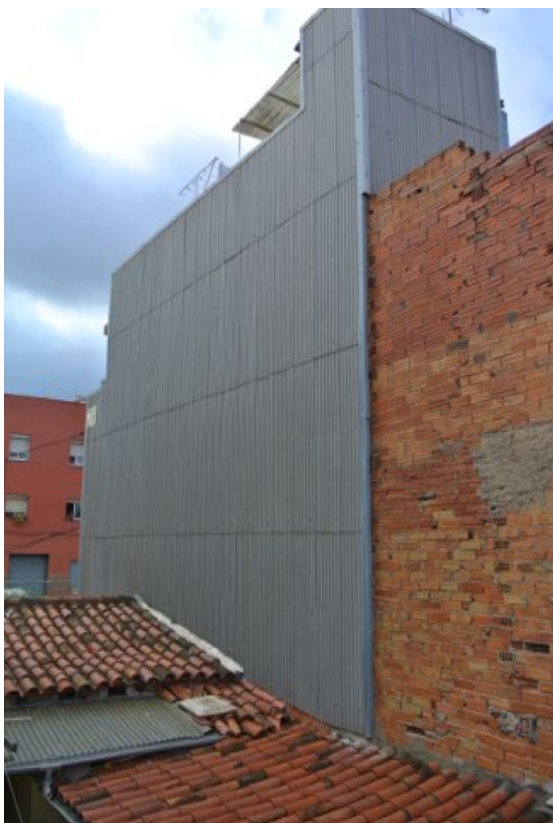
Vista de la mitgera de l'edifici n° 139
