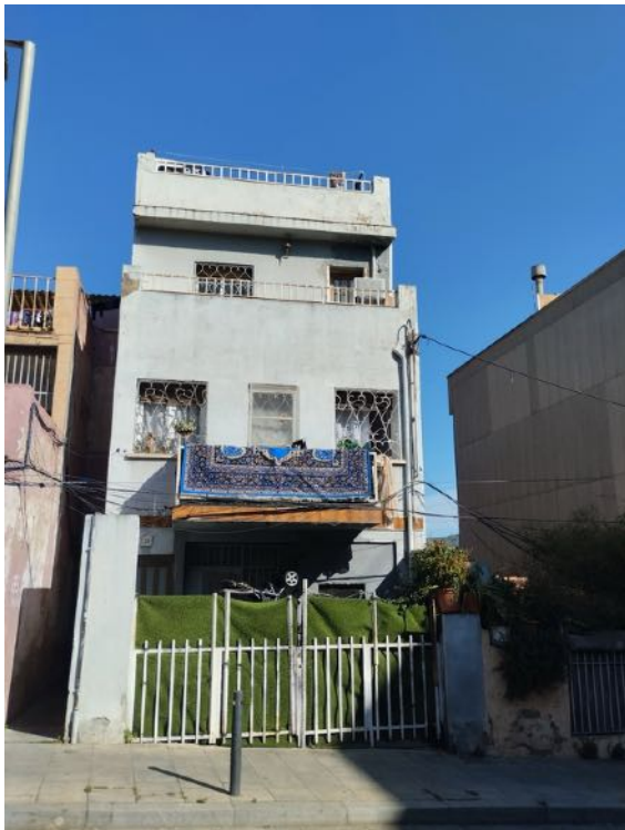
Vista de la façana principal de l'edifici a enderrocar
