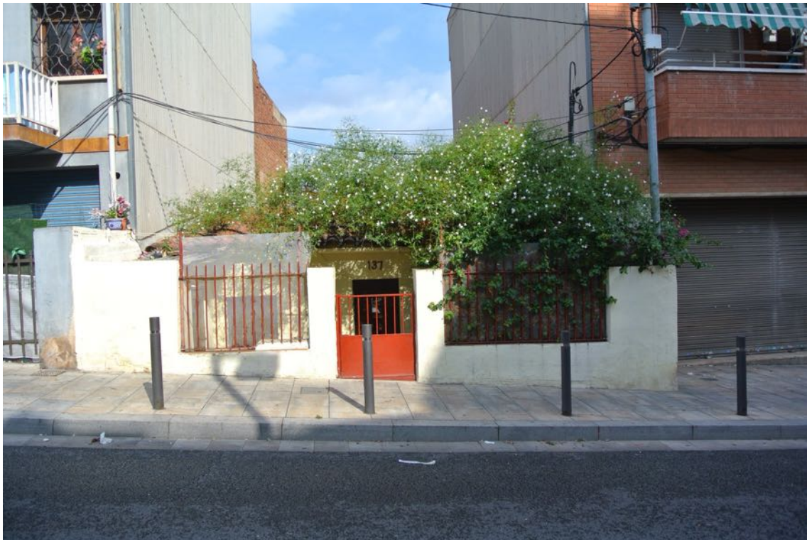
Vista de la façana principal de l'edifici a enderrocar
