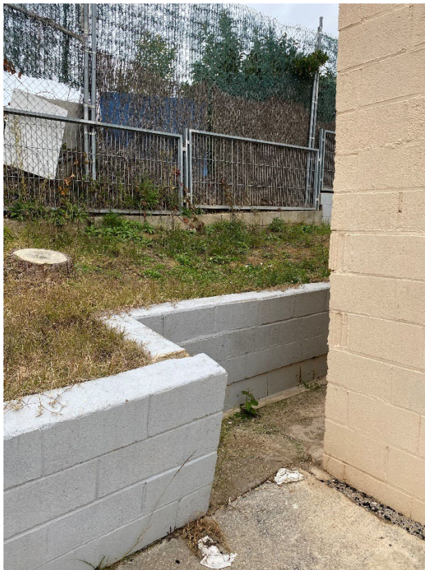
F.02 Trencament del mur i inclinació cap a la pista en diverses.
