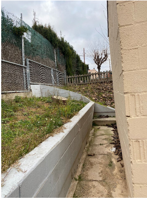
F.03 Continuació del mur darrere de la caseta d'emmagatzematge.
