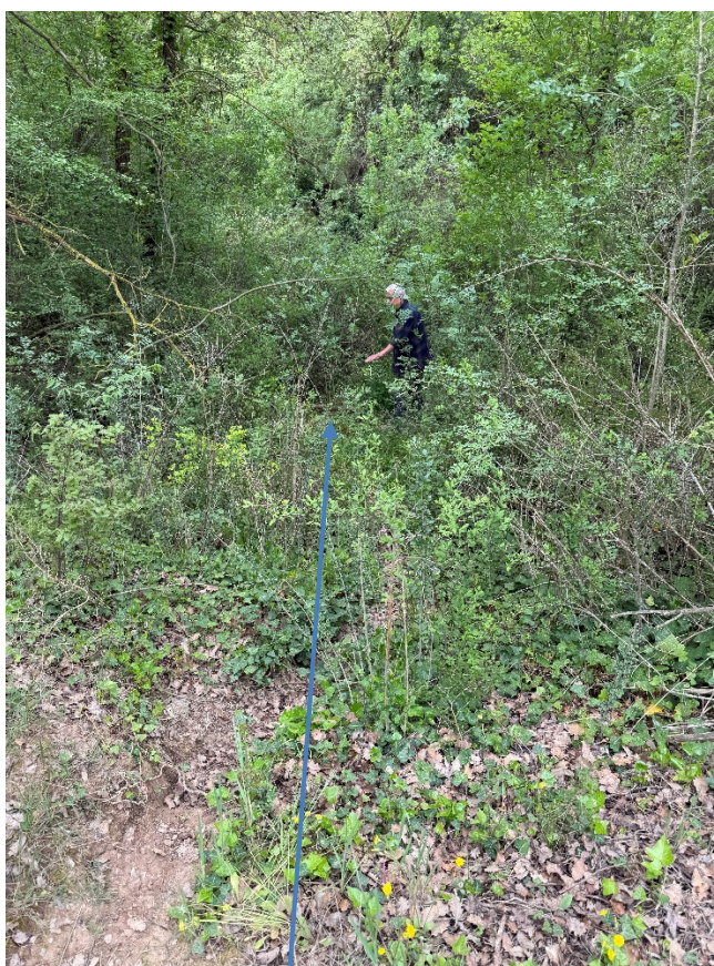
Tram de canonada arribant a la riera, espai molt embrossat
