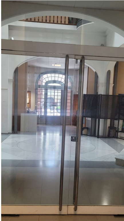
Porta interior batent comunicació CCAU i CSAU a substituir per porta automàtica accessible.
