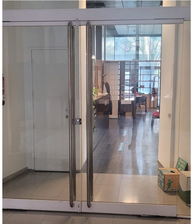
Porta interior batent comunicació CCAU i CSAU a substituir per porta automàtica accessible.
