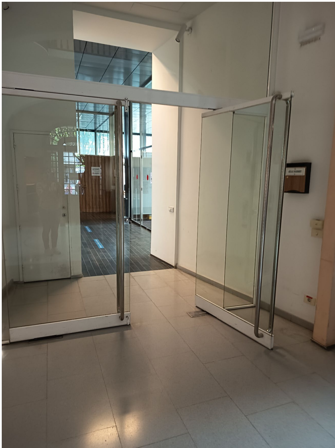
Fotografia núm. 4 – Porta entre els edificis del CSAU i del CCAU de planta baixa. Vista des de l'edifici de Consell Comarcal (CCAU)
