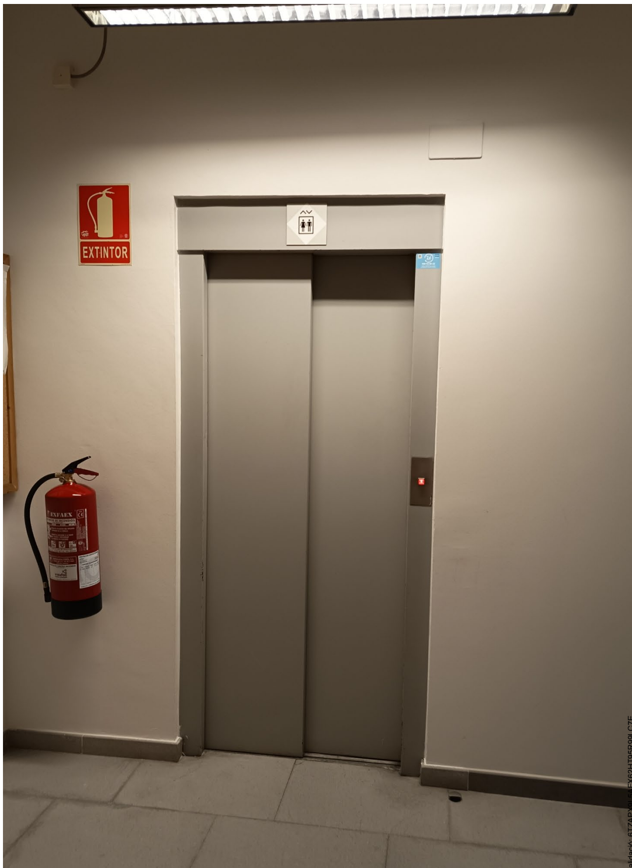
Fotografia núm. 8 – Porta de l'ascensor de planta baixa de l'edifici CCAU.
