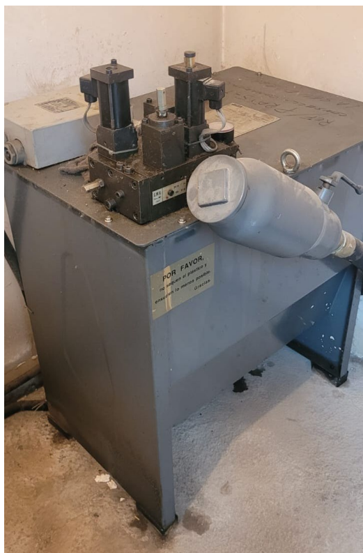
Ascensor hidràulic actual del CCAU a substituir per obsolet recanvis i peces d'antiguitat.
