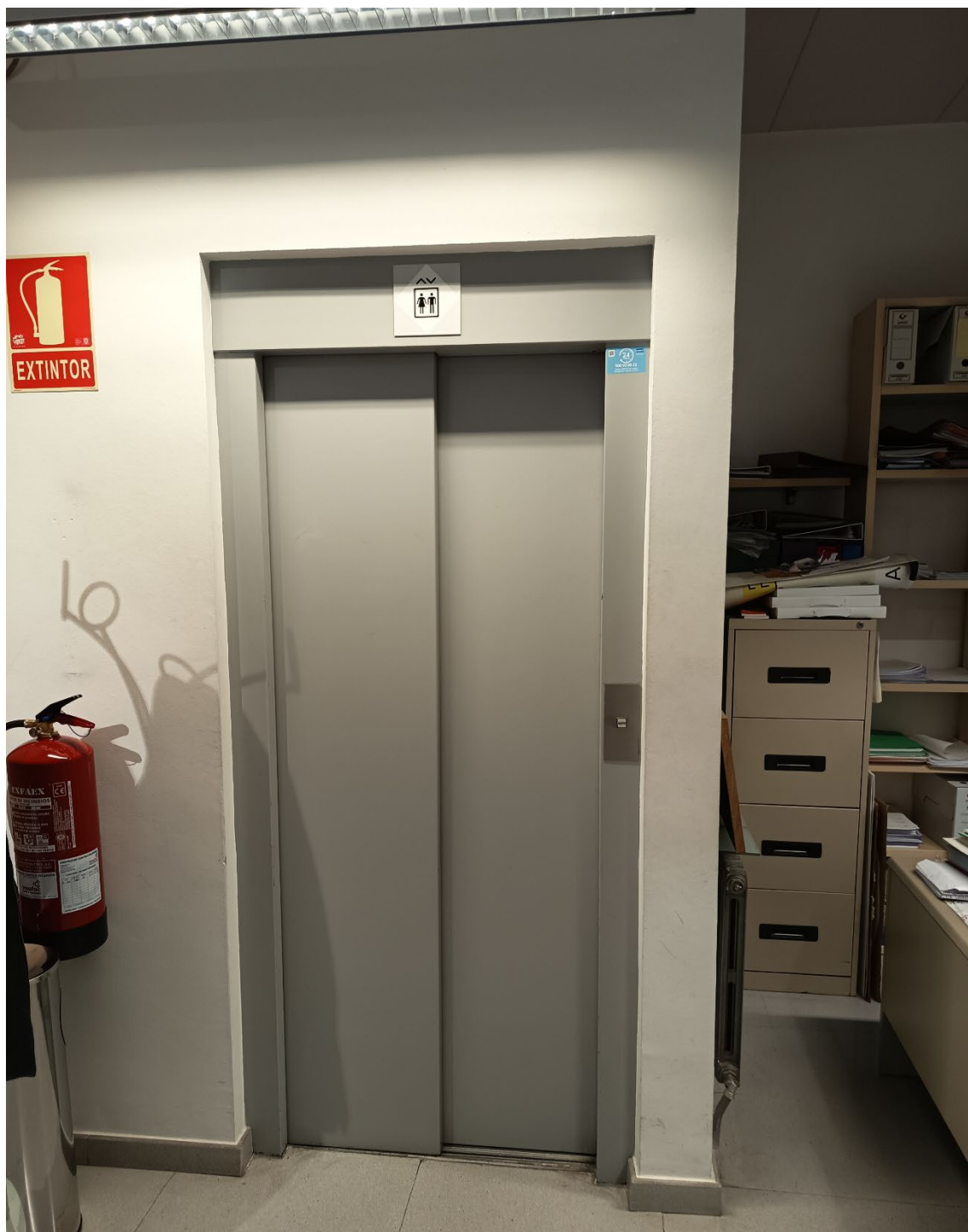
Fotografia núm. 9 – Porta de l'ascensor de planta primera de l'edifici CCAU.
