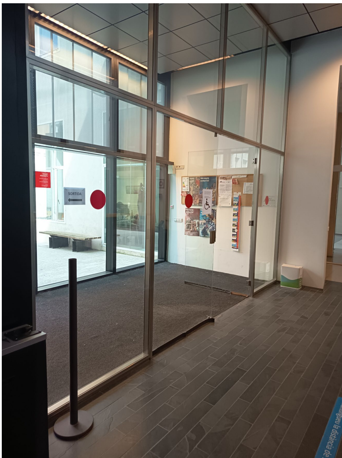
Fotografia núm. 3 – Accés a l'edifici de CSAU. Vista de la porta abatible a substituir des de l'interior (vista esquerra)
