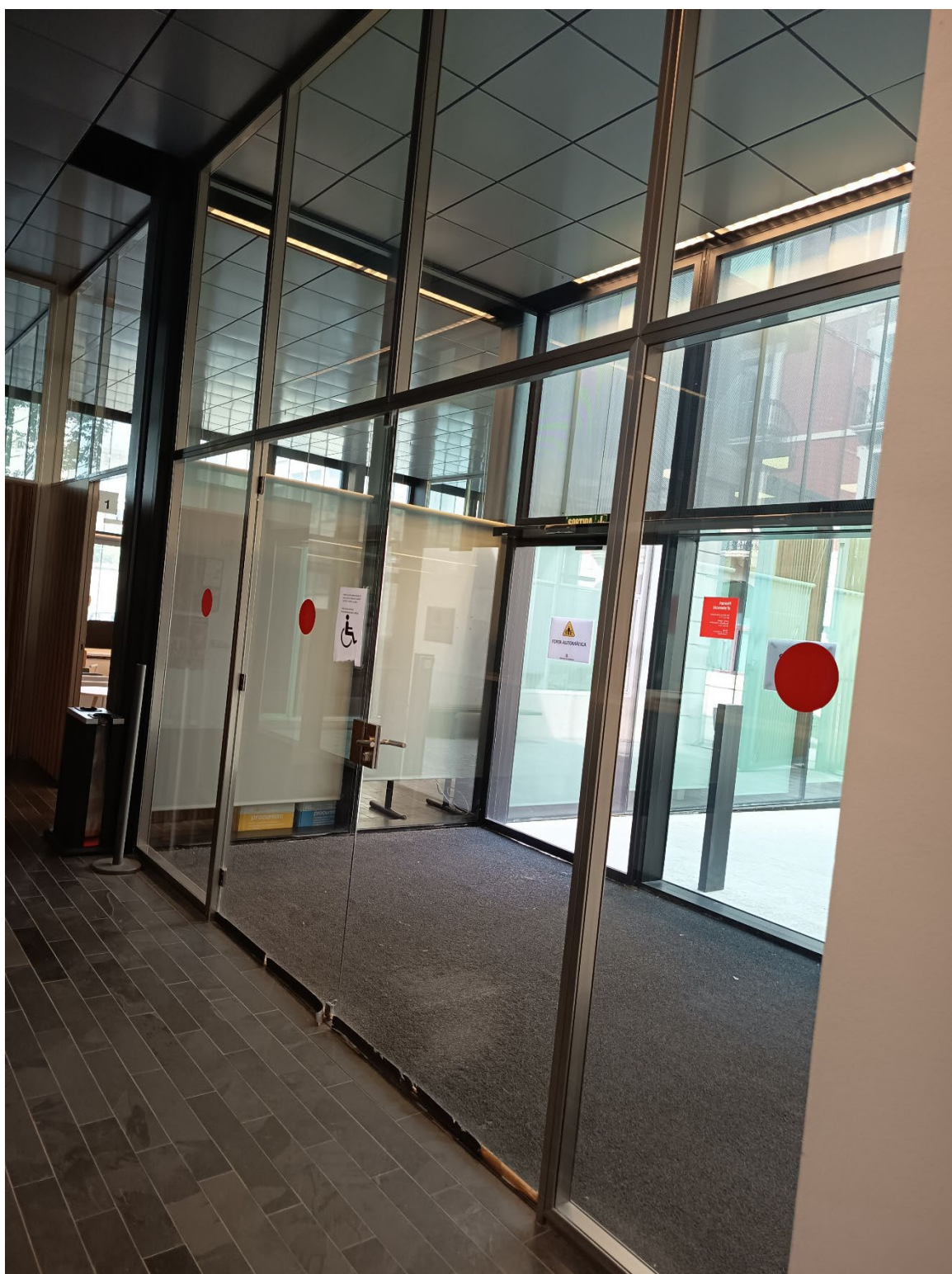
Fotografia núm. 2 – Accés a l'edifici de CSAU. Vista de la porta abatible a substituir des de l'interior (vista dreta)
