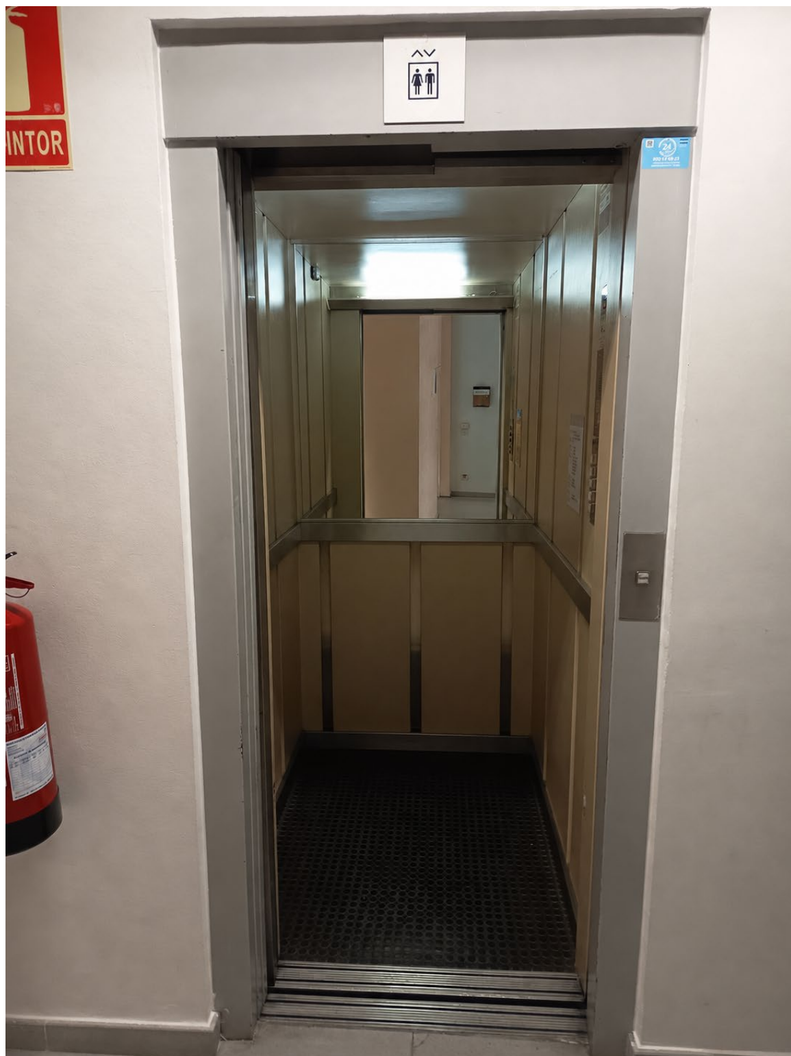
Fotografia núm. 11 – Interior de l'ascensor de l'edifici del CCAU
