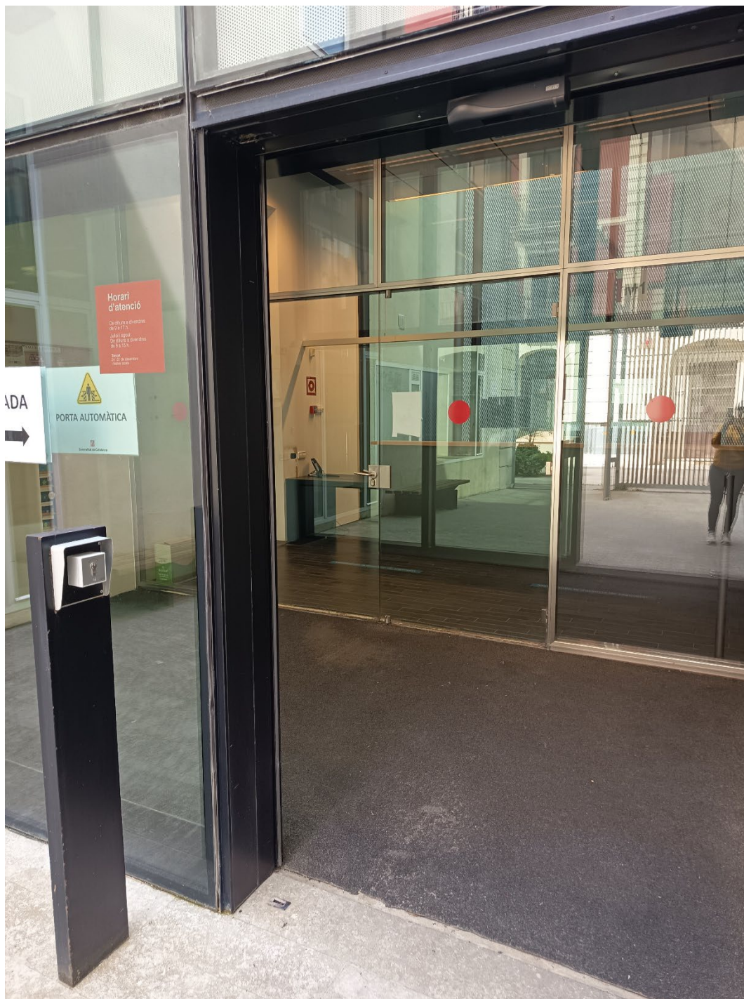
Fotografia núm. 1 – Accés a l'edifici de CSAU. Vista de la porta abatible a substituir des de l'exterior
