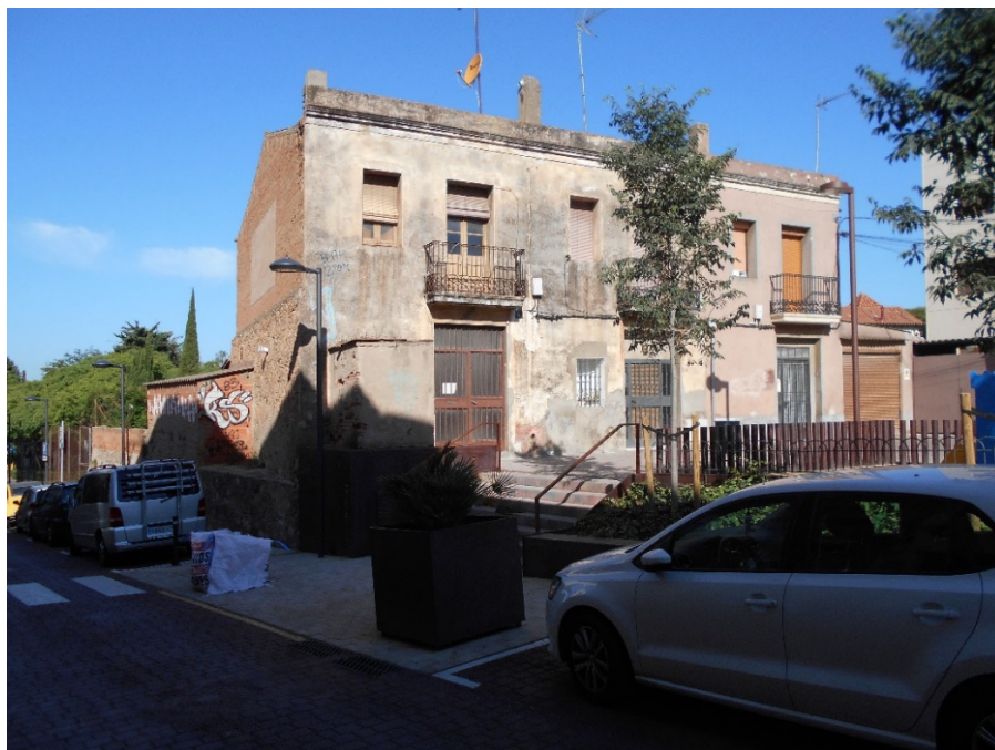
Vista de la 1a edificació entre mitgeres, pl. Estudis Vells 4
