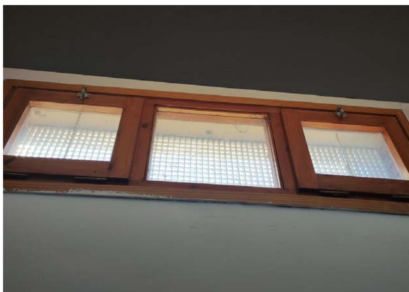
Finestra tipus 1 façana est - vista interior edifici
