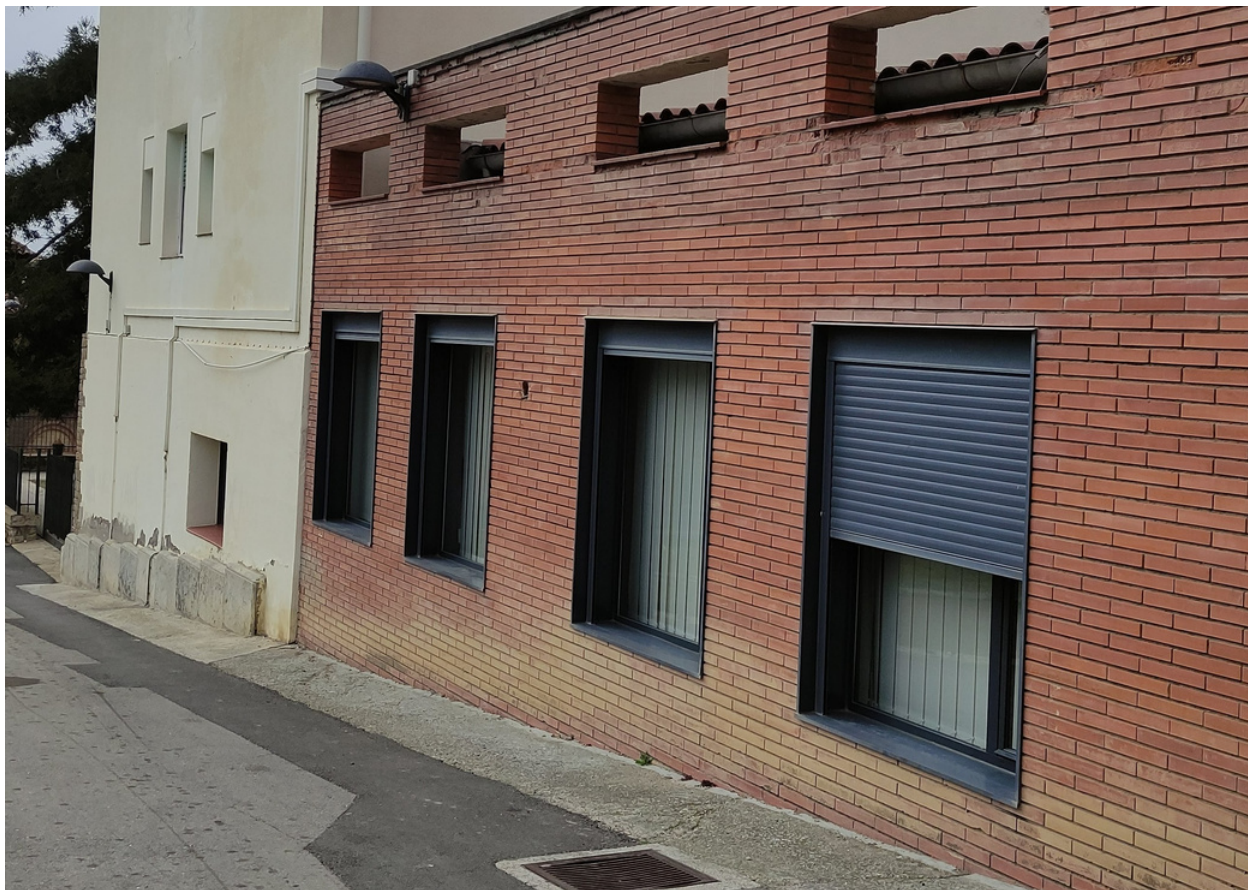
Façana est- finestres ja instal·lades tipus alumini
