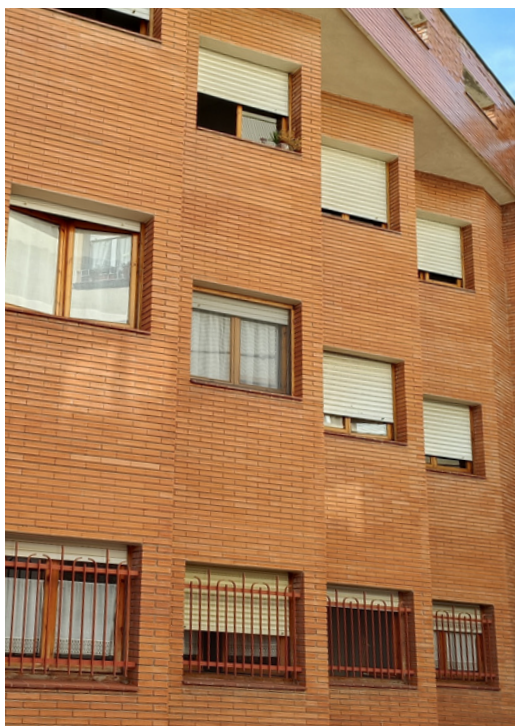
Finestres façana nord - 2
