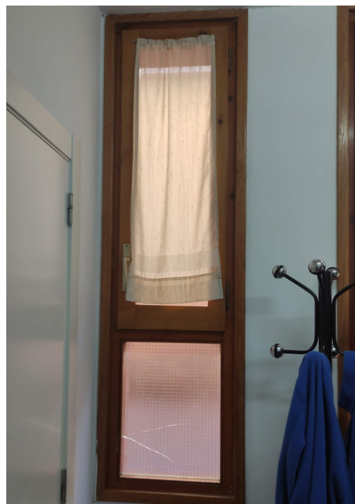
Finestra tipus 3 façana nord. Vista interior edifici
