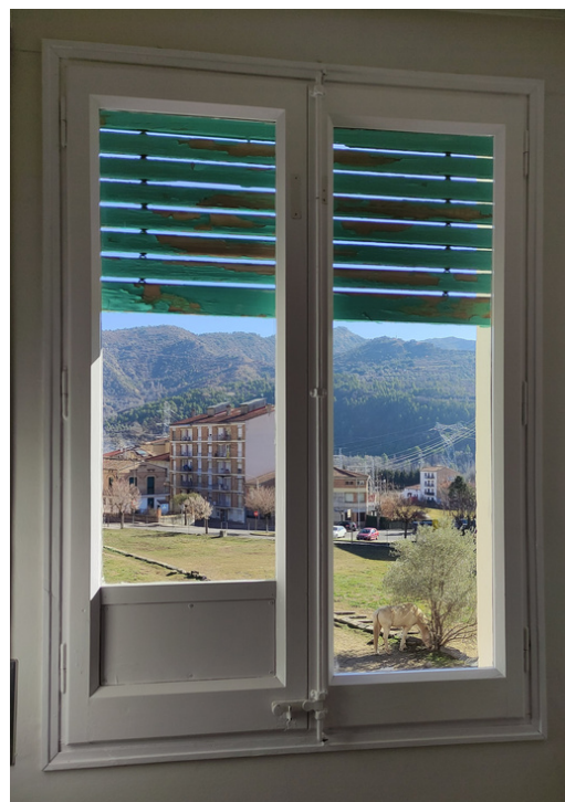
Finestra tipus 2 façana est. Vista interior edifici
