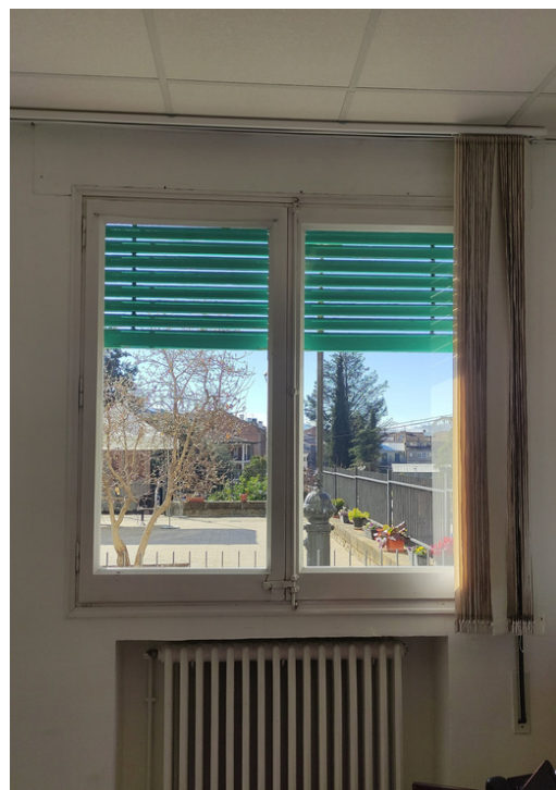
Finestra tipus 1 façana sud. Vista interior edifici
