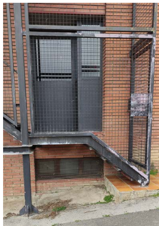
Finestra tipus 1 façana est
