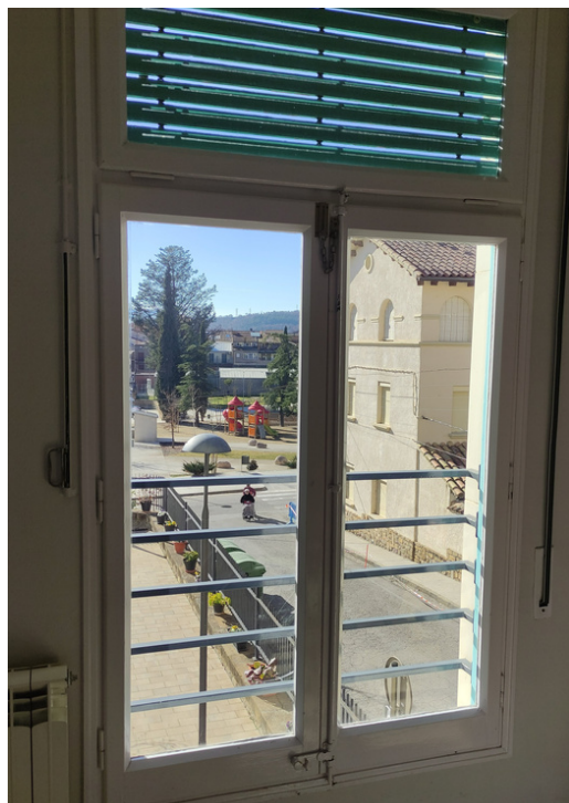
Finestra tipus 2 façana sud. Vista interior edifici
