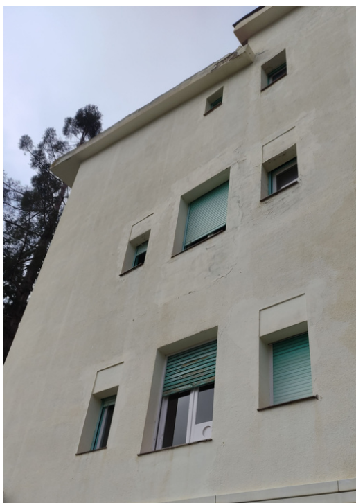
Finestra tipus 2 façana est
