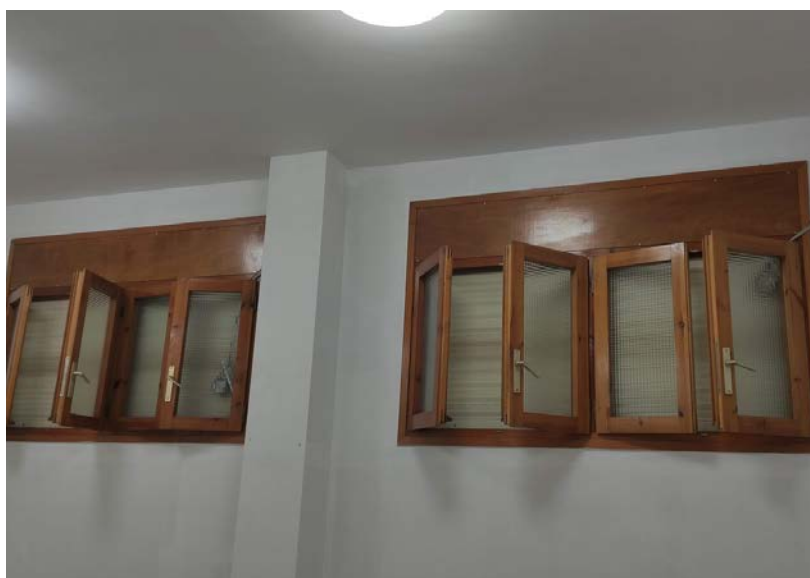
Finestra tipus 2 façana nord - vista interior edifici
