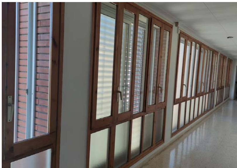
Finestra tipus 2 façana oest - vista interior edifici
