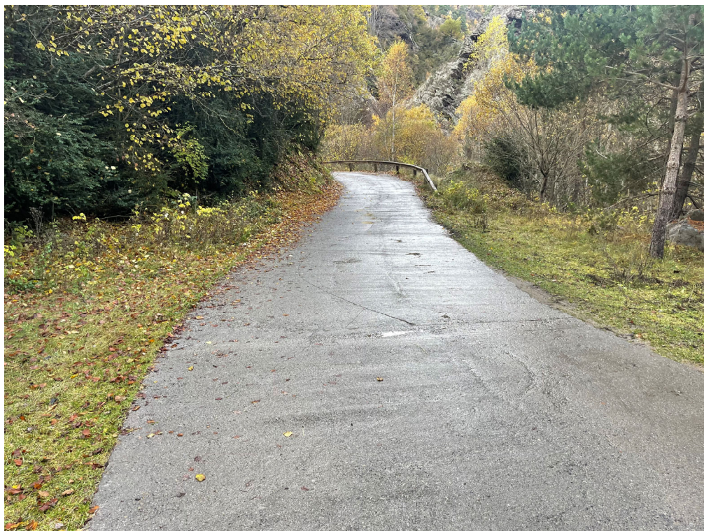
Imatge 4: punt de la carretera de Tor, on es creua el camí, i es comença a soterrar la canonada es a la carretera.
