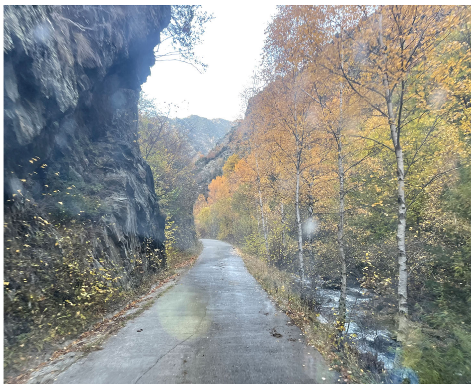
Imatge 5: carretera de Tor per on es soterra la canonada de PE.
