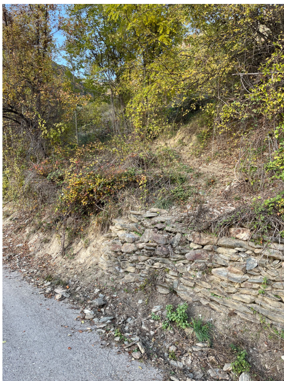
Imatge 7: Desviament canonada de la carretera de Noris cap a depòsit.
