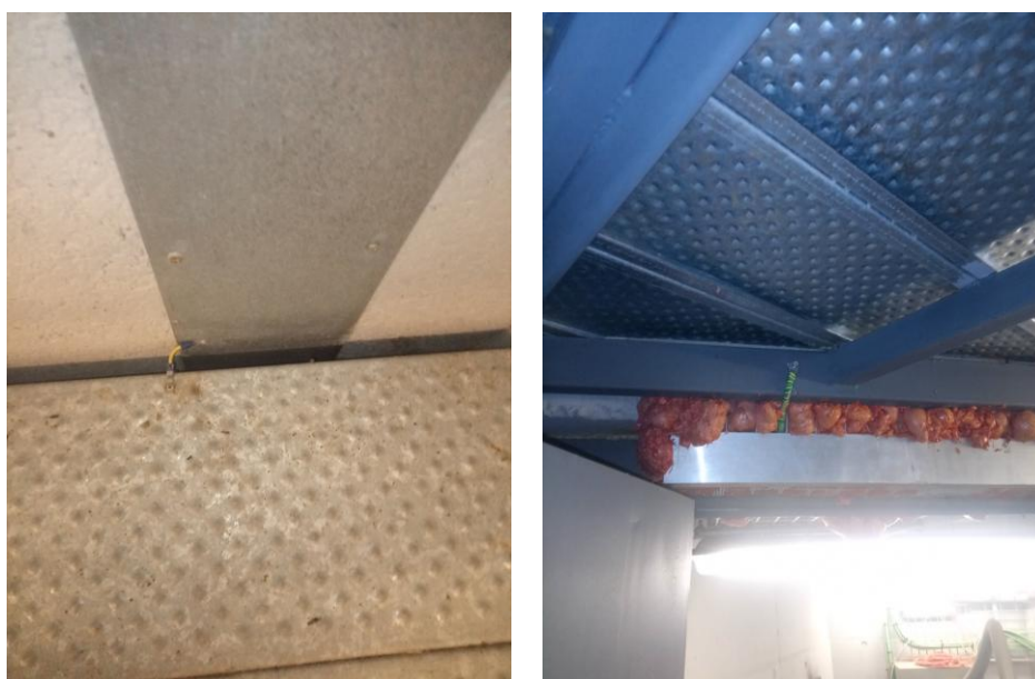
Figura 13 - Conexiones equipotenciales
