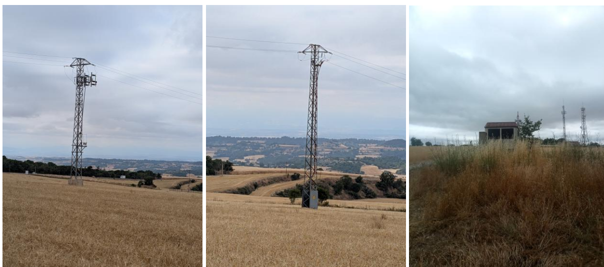
Figura 14 - Conmutación de línea aérea a subterránea
