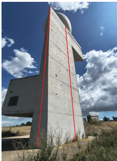
Figura 32 - Ubicación de las dos bajantes específicas
