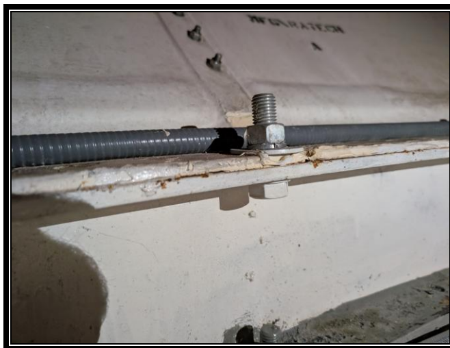
Figura 30 - Anillo metálico de la base del radomo
