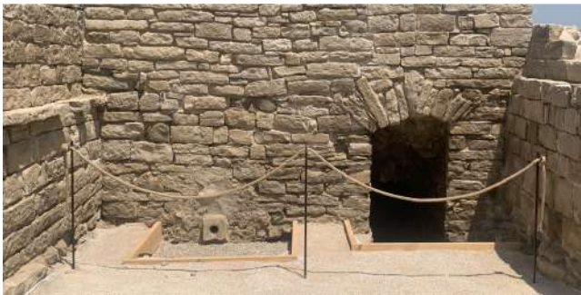
Element separador executat a la Etapa 1 del Pla director.
