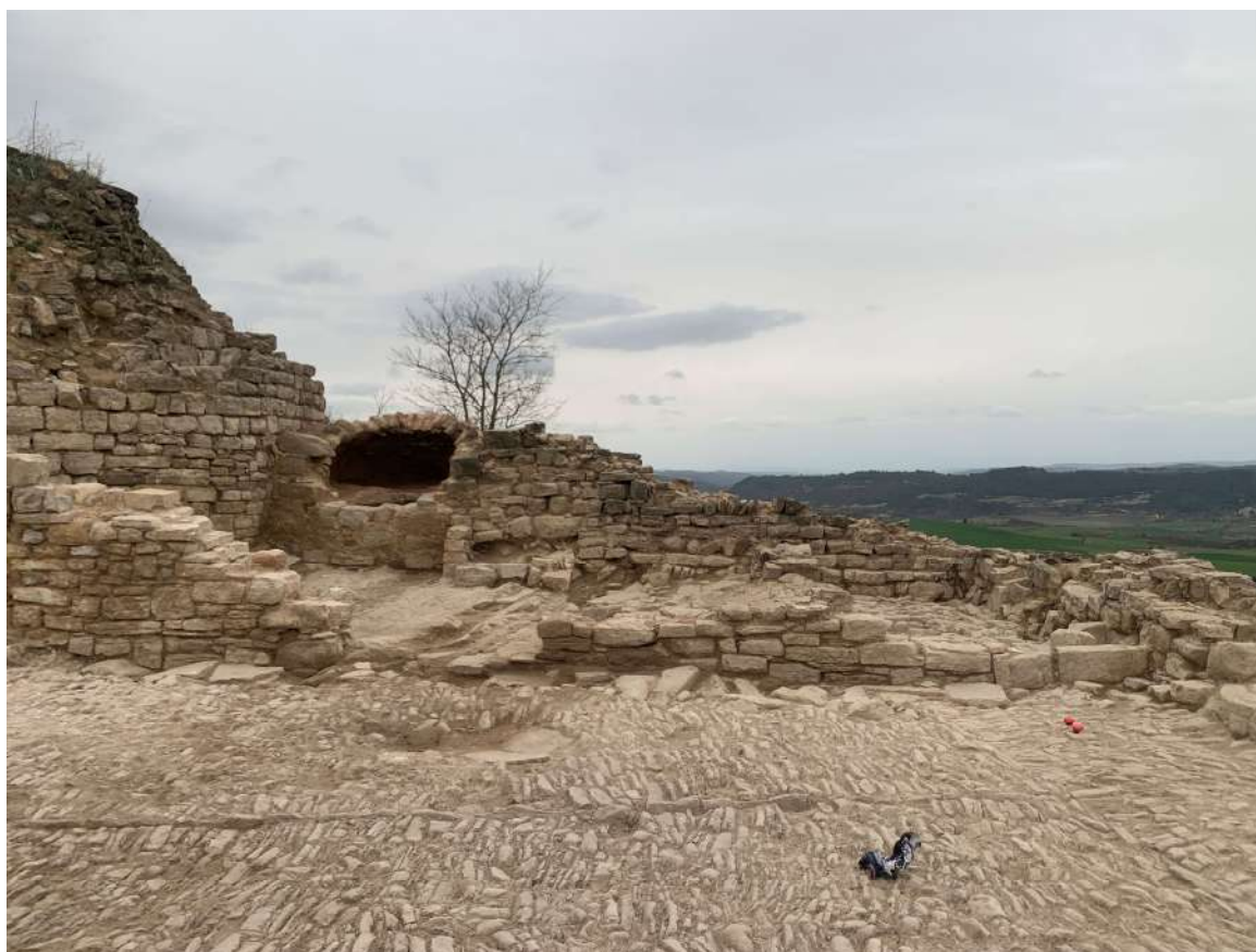
Edifici 3 vist des del pati. A la dreta, mur nord d'accés. A l'esquerra, el forn al peu de la torre. Font: Roger Guitart i Domingo
