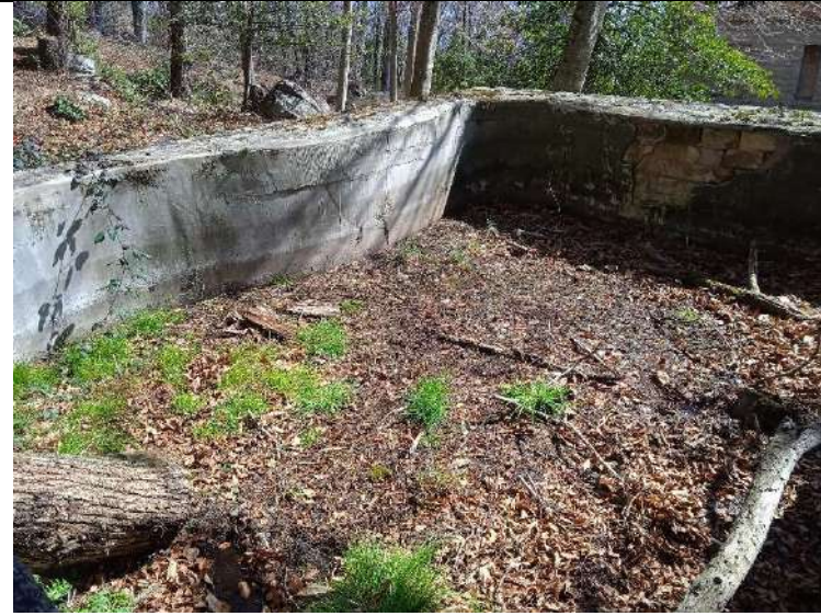
Bassa gran. Neteja, repicat i impermeabilització de bassa. Construcció d'una rampa antiofegament per a fauna
