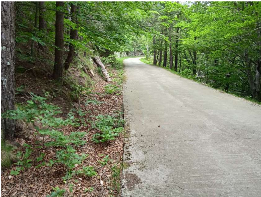
Tram de pista pavimentat on la rasa serà per la cuneta.
