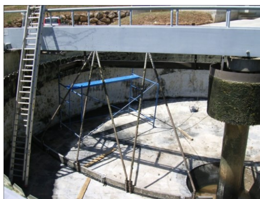
Detall dels elements actuals referents a les pales i rascadors del pont
