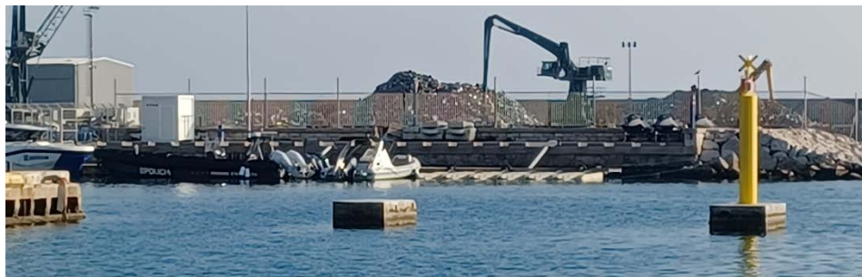
Fotos 1. Detall piles aïllades existents
