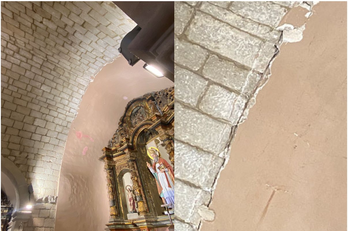
Constant moviment entre l'àbssis i la volta de canó.
