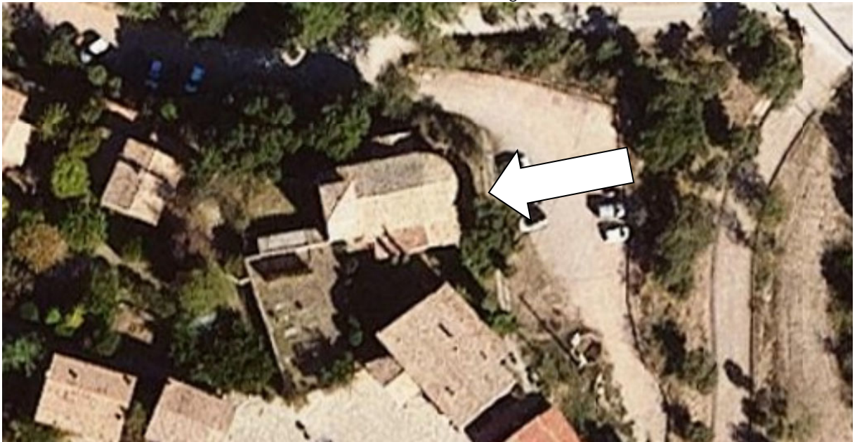
Ortofoto extreta del visor de l'ICGC. La fletxa indica l'emplaçament de les obres
