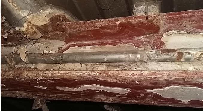
Después de Limpieza
