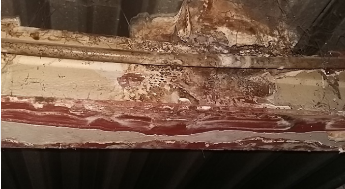
Después de Limpieza
