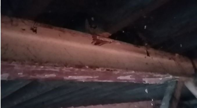
Después de Limpieza
