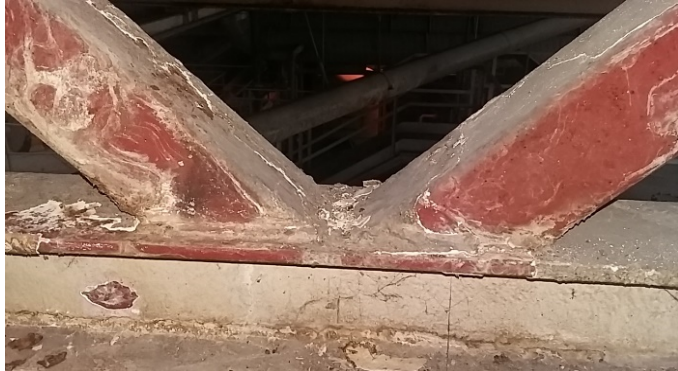
Después de Limpieza
