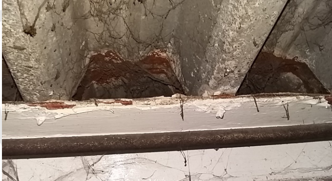
Después de Limpieza
