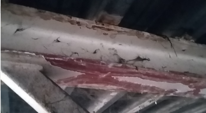
Después de Limpieza
