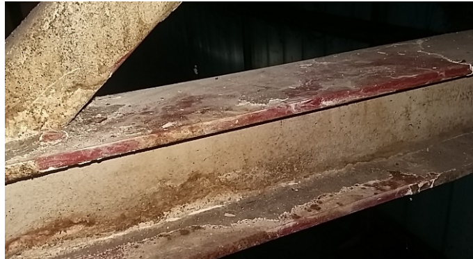
Después de Limpieza
