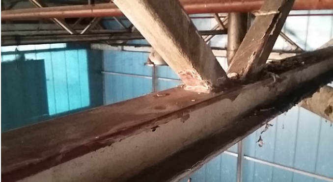
Después de Limpieza
