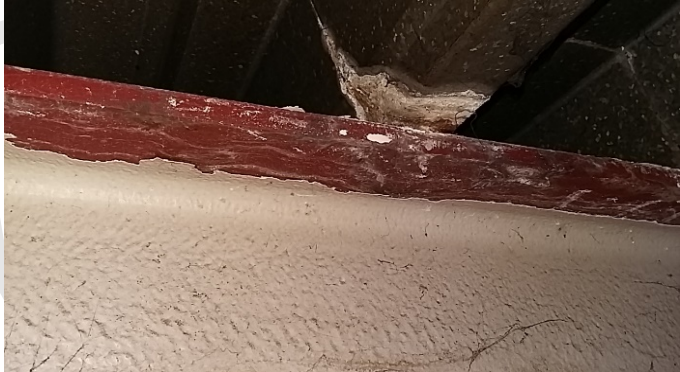
Después de Limpieza
