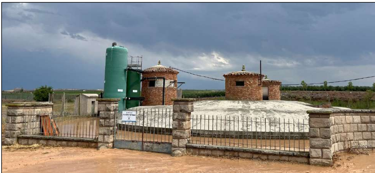
Fotografia 8. Coberta dels dipòsits 1 i 2, situats a la Ctra. de Juneda. 2.000 m³ cadascun.
