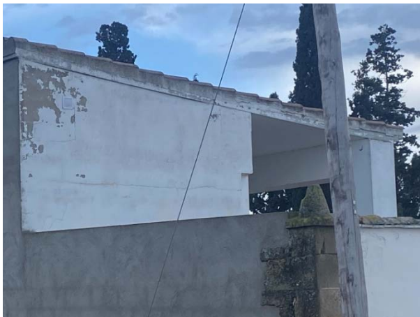
Detall de paraments afectats per humitats
