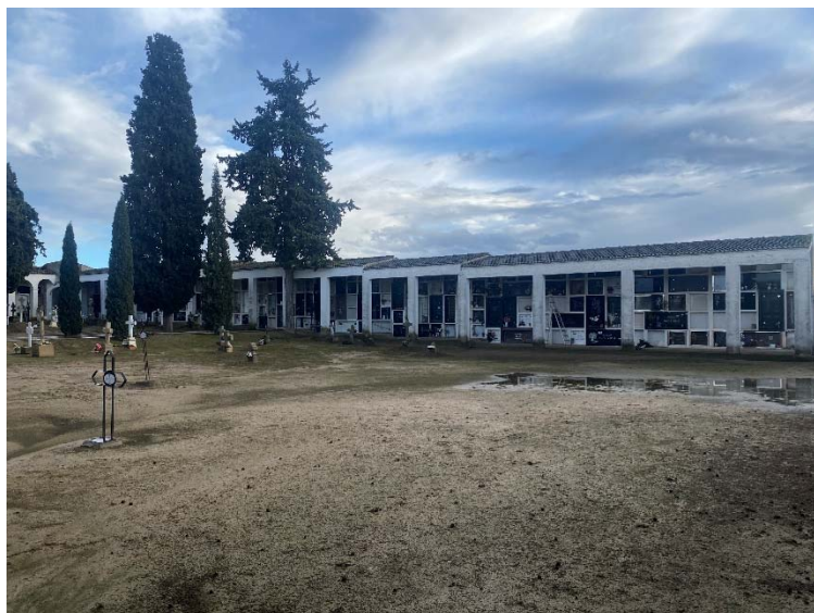
Vista general del bloc 6
