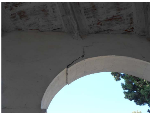
Detall de patologia del parament porticat
