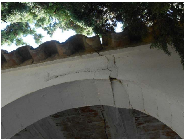
Detall de patologia del parament porticat
