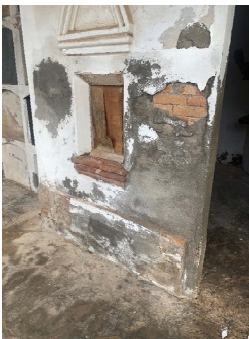
Detall de patologies en paraments verticals
