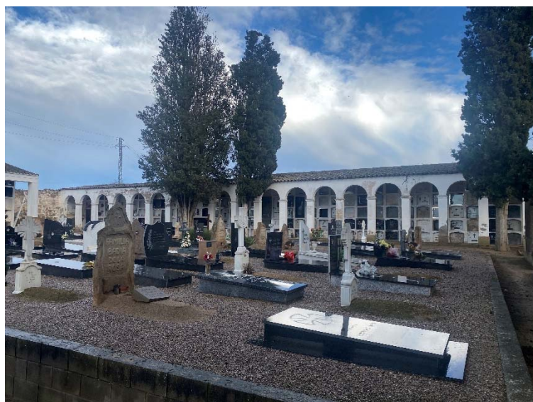
Vista general del bloc 4
