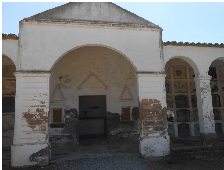
Vista general de la morgue
