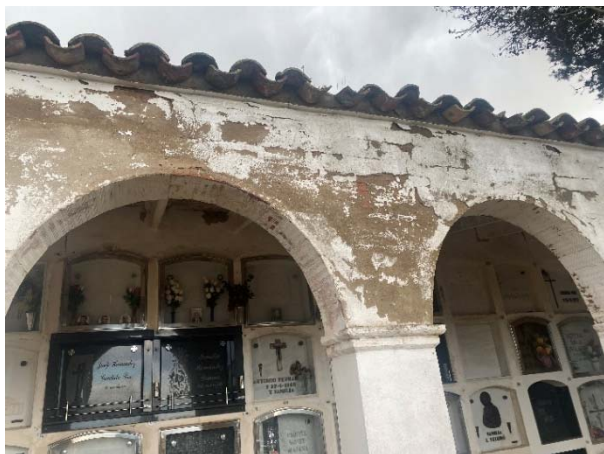
Detall de paraments afectats per humitats
