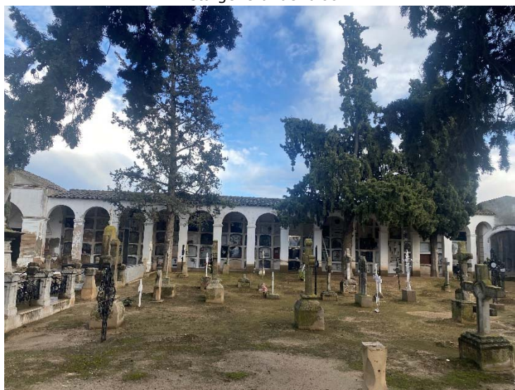
Vista general del bloc 5
