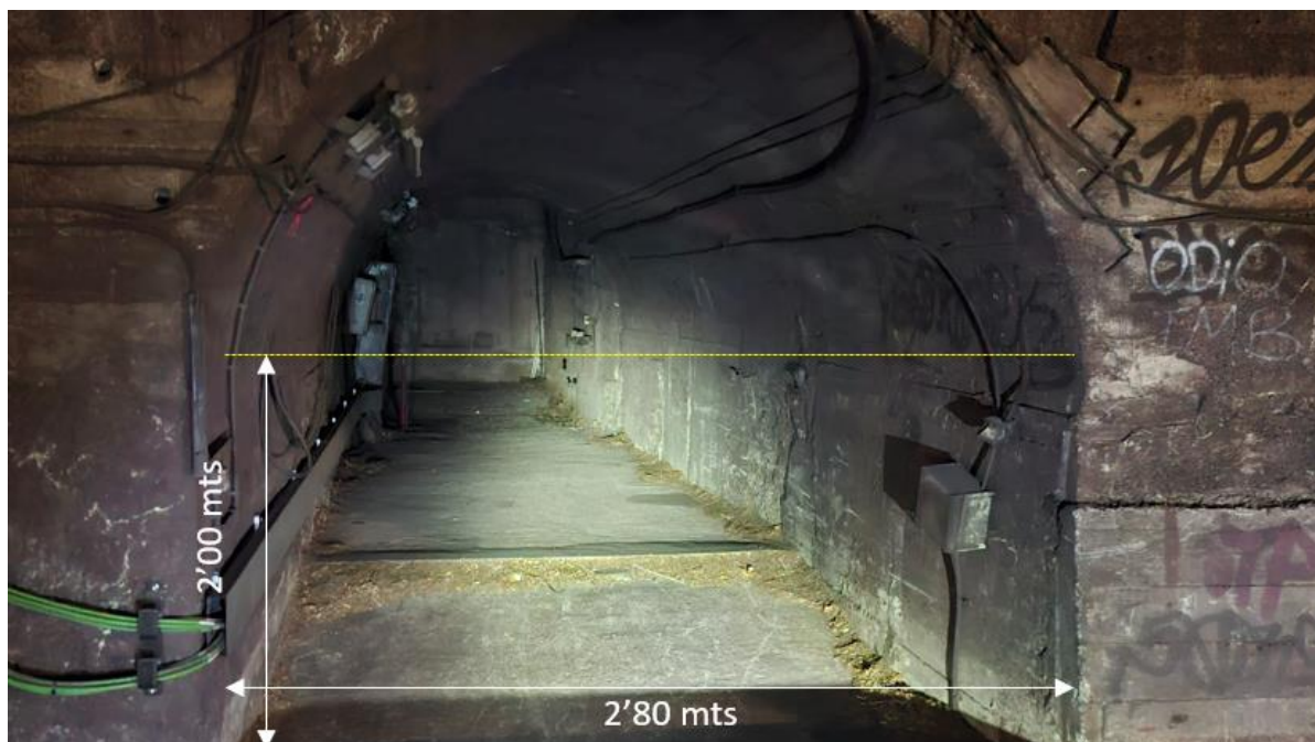
Plànol 8. Imatge de la galeria de serveis.
