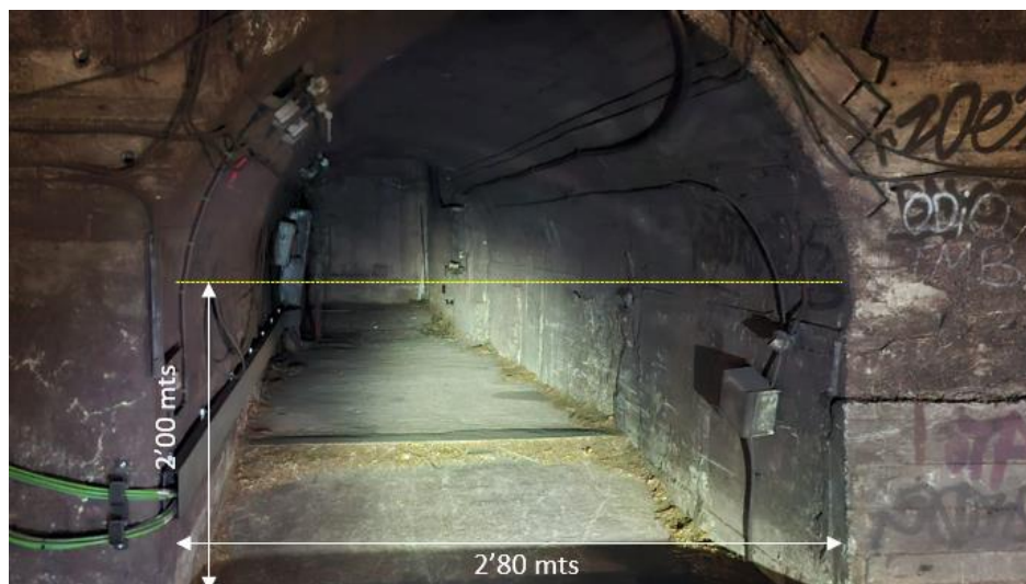
Imatge 5. Imatge detall galeria per abassegament de maquinària i material al costat lateral de via 2. Font: F.M.B.
