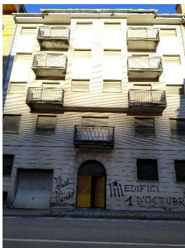
Estat Actual de la Façana
