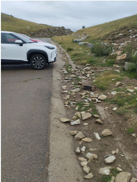
Cuneta de formigó del costat sud.
