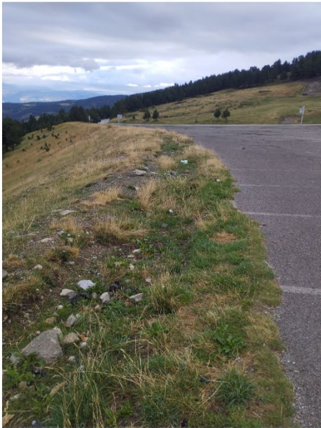
Cuneta de terra situada al costat oest.
