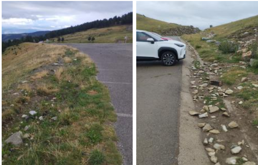
Figura 5. Vista dels elements de recollida d'aigües pluvials
