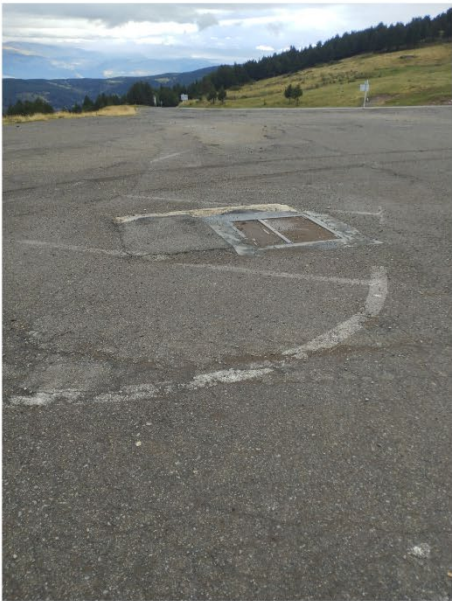
Arqueta dins del aparcament
