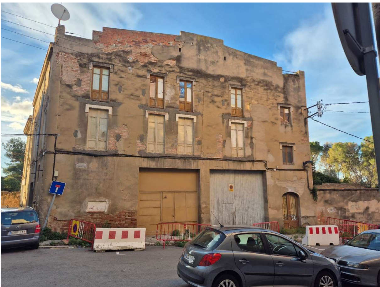
1.Façanes C/ Hort dels Alls
