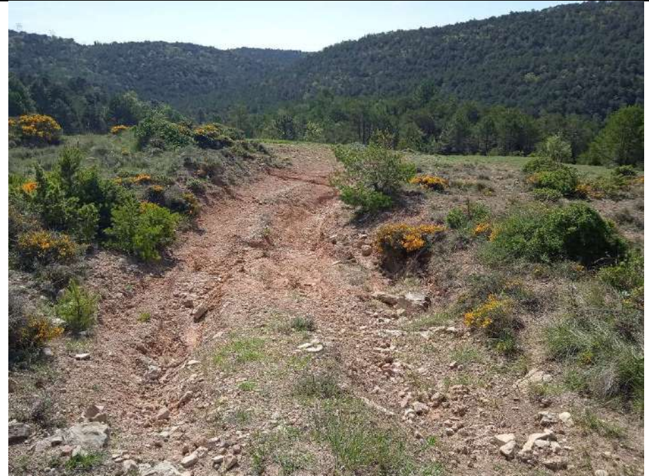
Estat de la pista d'accés a la zona de treballs on es preveu condicionar l'accés per a la maquinària tant d'execució de treballs com d'extracció dels productes obtinguts
