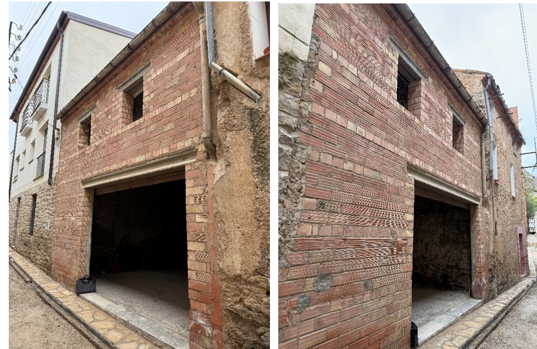
Fotografies 3 i 4. Vistes de la façana cap al carrer Raval i les obertures a l'exterior
