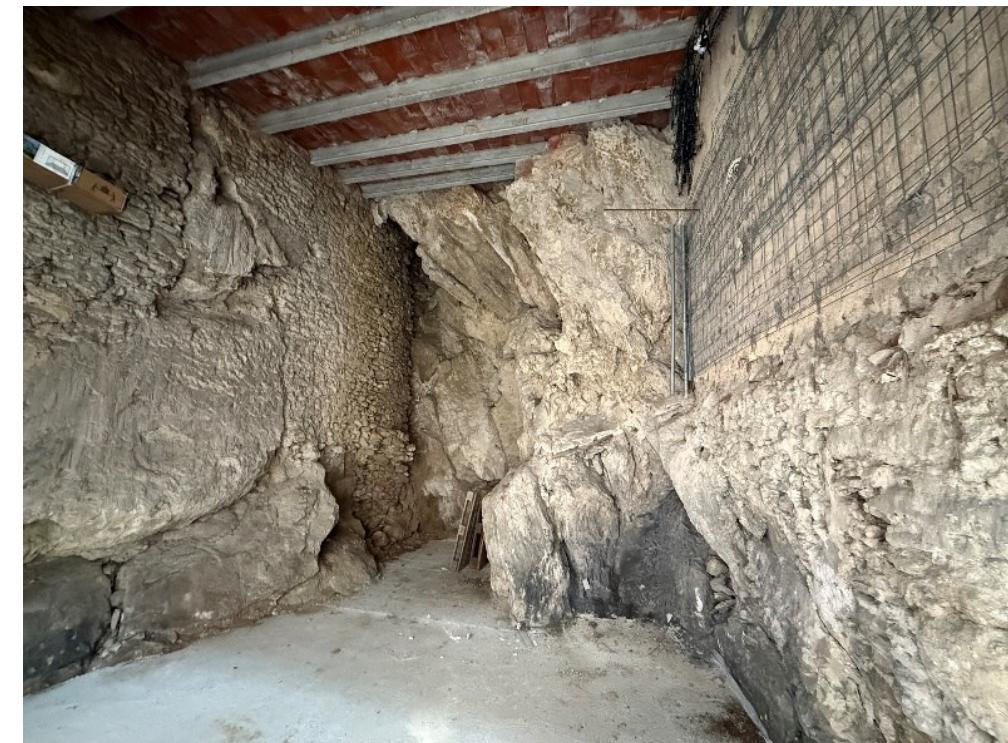
Fotografia 1. Imatge interior del volum diàfan amb les mitgeres de bolons adaptats a la roca nua existent.
