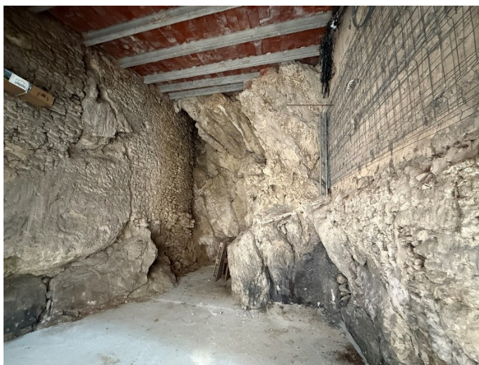
Fotografia 1. Imatge interior del volum diàfan amb les mitgeres de bolons adaptats a la roca nua existent
