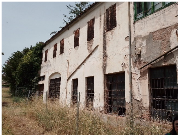
Exterior antiga fàbrica
