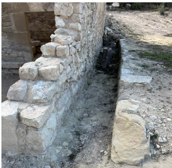
Accés a desguàs pendent excavació
