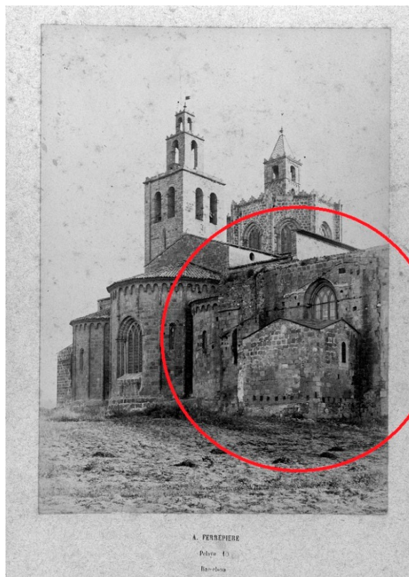
Capella de Sant Benet per l'exterior entorn 1880-1890. S'hi observa la coberta de rajola realitzada entorn el 1880, i també per sobre de l'alçada de la imposta de la sala capitular, un traç blanc que es pot interpretar com la trobada de l'anterior coberta de teula amb el mur [Foto: A. Ferrepiere]
