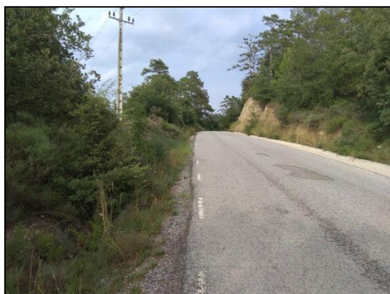
Figura 2. 0+000 Rampa de pendent elevat amb cuneta erosionada. Figura 3. 0+207 Aparició de flonjall.
