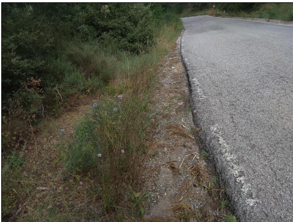
Figura 3.- Pk 0+100. Pk final execució cuneta ME..
