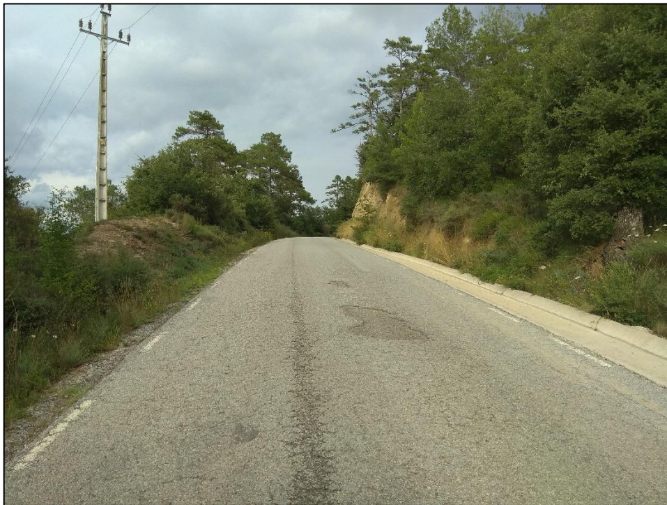
Figura 1.- Pk 0+000. Inici de l'obra. Forats al centre de la ctra. veïnal. Tram a reforçar.
