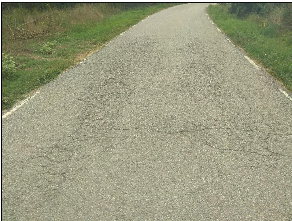
Figura 4.- Pk 1+183. Pell de cocodril a tota l'amplada del vial.
