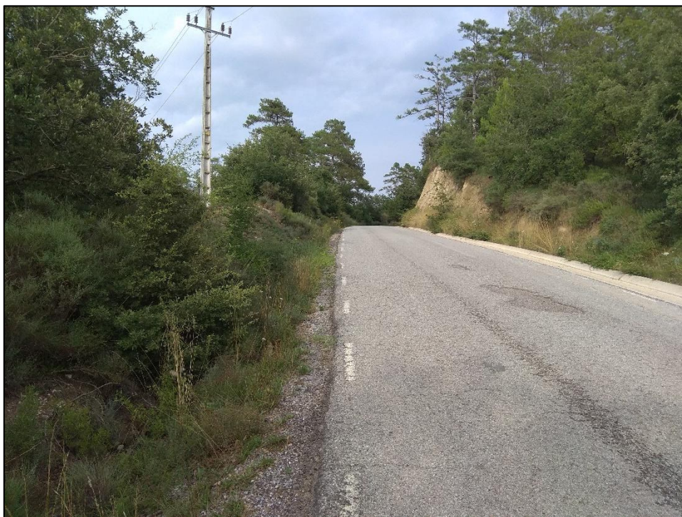
Figura 2.- Pk 0+00. Execució de nova cuneta TTR-10 al ME.
