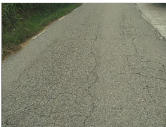
Figura 2. 0+000 Rampa de pendent elevat amb cuneta erosionada. Figura 3. 0+207 Aparició de flonjall.
