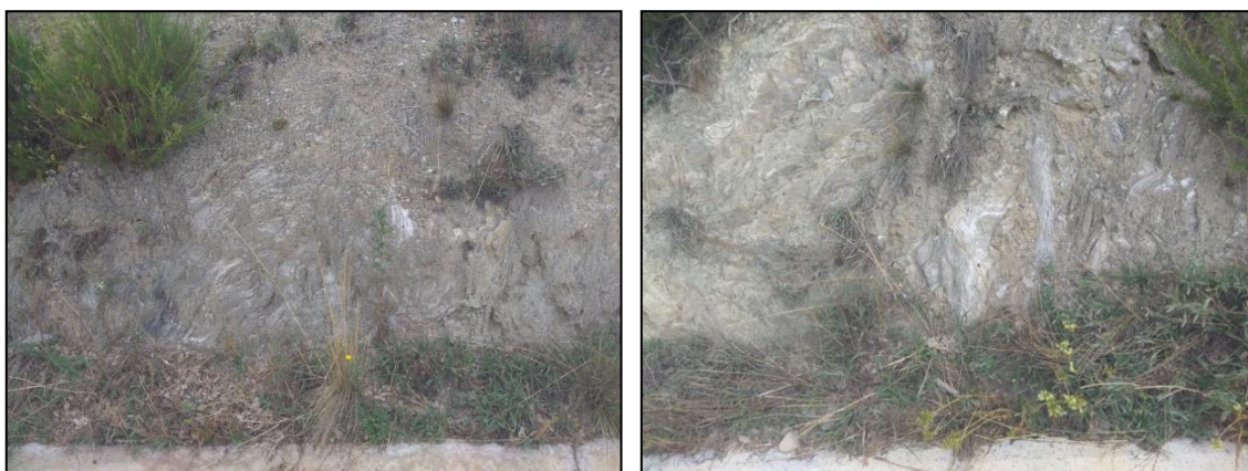
Figura 2 i 3. Aflorament de guixera al talús del ME en el pk 0+373 i en el PK 1+425 on cal excavar en desmunt i en caixa.
