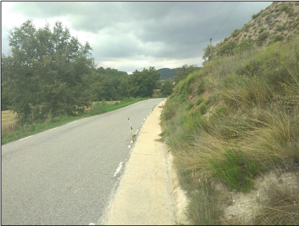
Figura 11.- Pk 1+418. Correcció del traçat. Posteriorment es tornarà a fer cuneta revestida de formigó.
