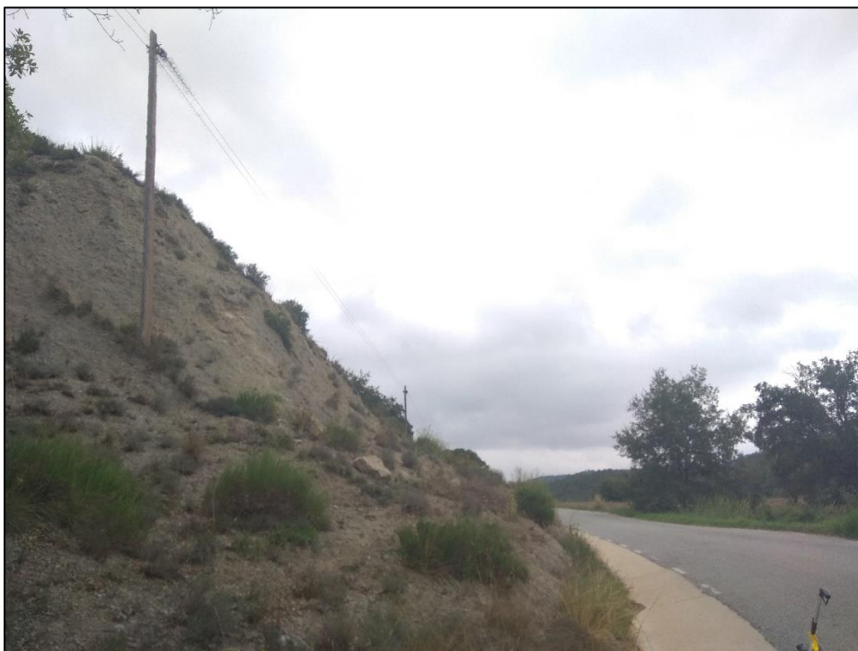
Figura 7.- Pk 1+365ME. Correcció revolt per millorar la visibilitat.
