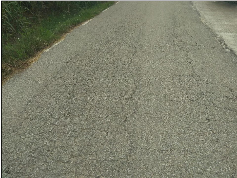
Figura 5.- Pk 1+207. Reparació de flonjall en tota l'amplada del vial.
